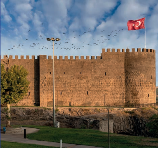
Görsel 2.82: Diyarbakır Kalesi ve Surları
