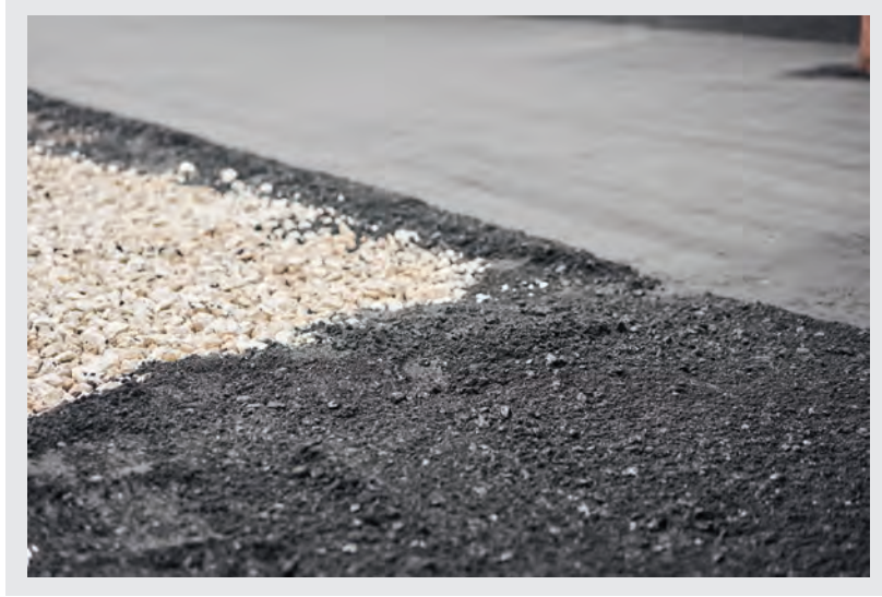
Görsel 9.2.4: Beton zeminler
