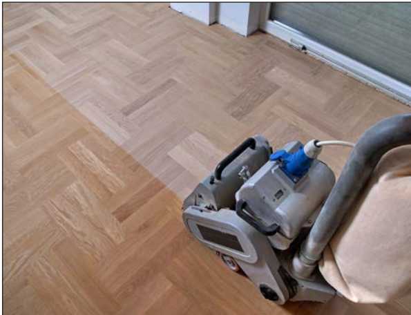
Görsel 2.15: Ahşap zeminden mevcut cilanın sökülmesi
