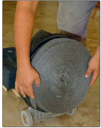
Görsel 2.12: Çelik pedin cila makinesine takılması
