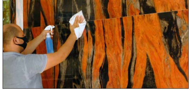
Görsel 2.23: Duvar temizliği
