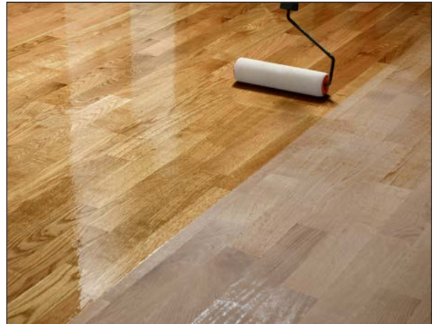
Görsel 2.16: Ahşap zemine rulo fırça ile cila uygulaması
