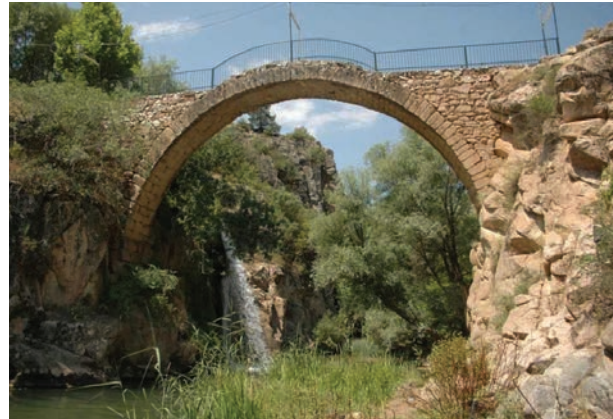
Görsel 8.12: Cılandıras Köprüsü-Uşak
