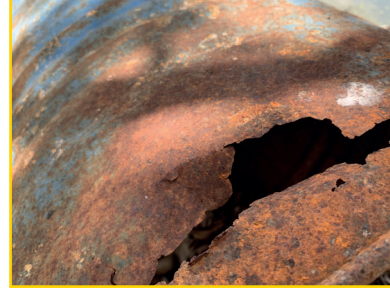
Görsel 1.22: Petrol tankında erozyon
