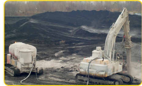
Görsel 3.12: Petrol döküntüsü kireç kullanılarak geri dönüştürme çalışması
