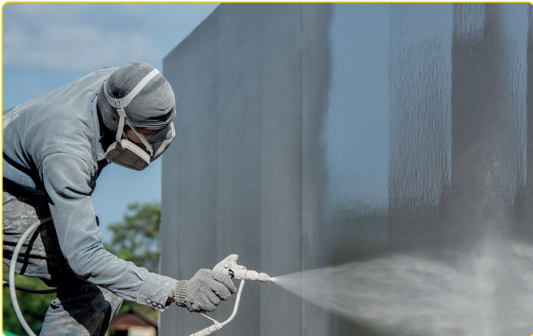
Görsel 1.23: Metal yüzeyi püskürtme tabancası ile boyama
