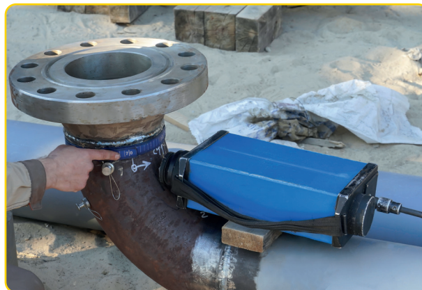
Görsel 1.11: Radyografi yöntemi ile korozyon kontrolü
