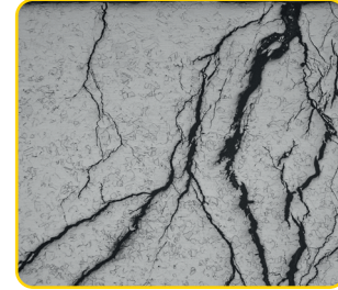
Görsel 1.8: Stres korozyonu sonucu oluşan çatlak
