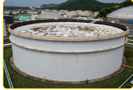
Görsel 2.11: Yüzer tavanlı depolama tankı
