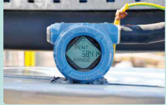
Görsel 4.2: Basıncı ölçen transmittter
