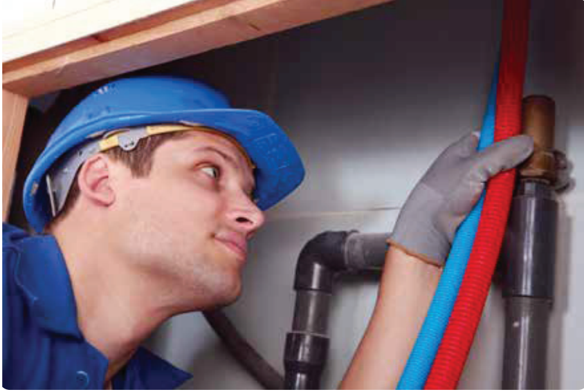
Görsel 1.9: Su tesisatındaki kaçakların kontrolü
