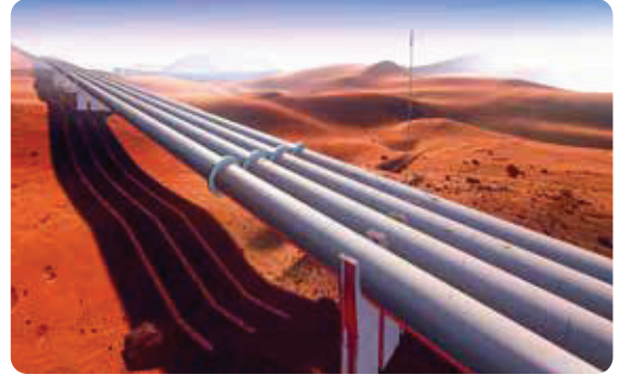
Görsel 7.5: Doğal gaz boru hattı
