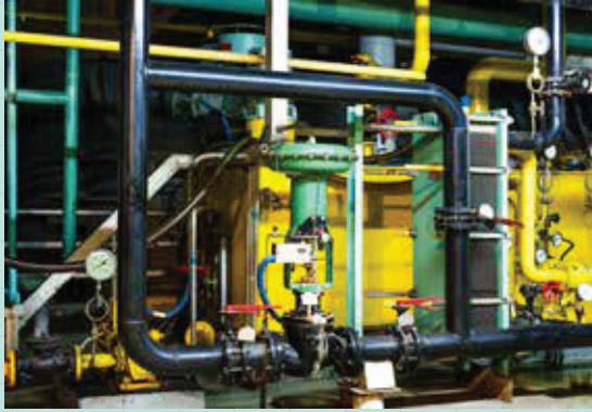
Görsel 1.9: Kalorifer sistemlerinde kullanılan vanalar
