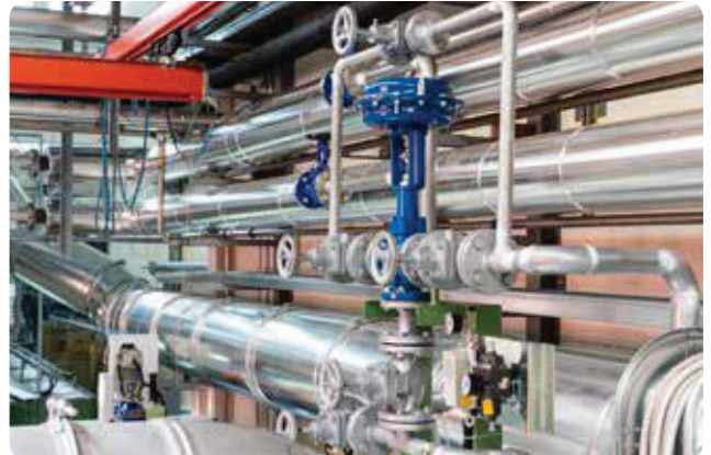
Görsel 7.6: Fırın sıcaklık kontrolü
