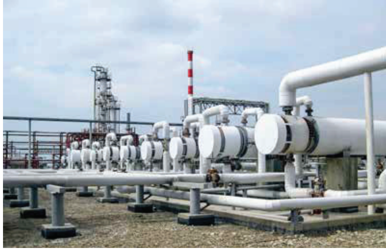
Görsel 5.6: Rafineride kullanılan ısı deęiřtiriciler
