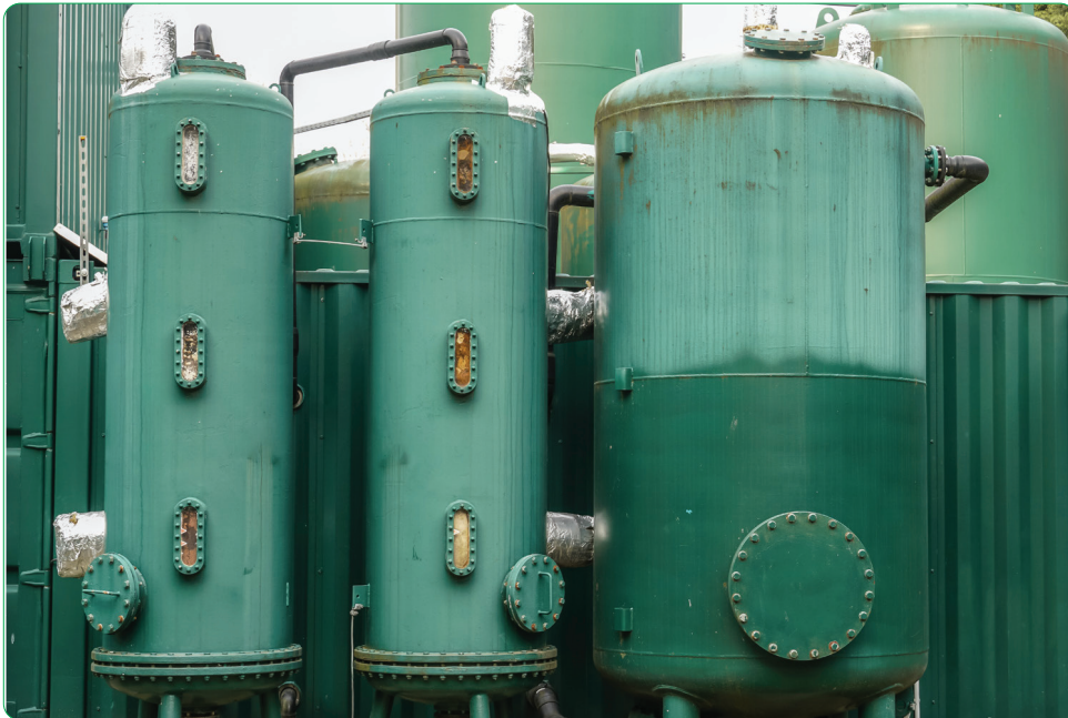
Görsel 7.8: Su arıtmada kullanılan endüstriyel iyon değiştiriciler
