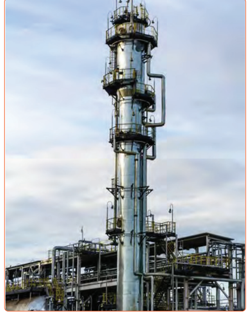
Görsel 10.8: Atmosferik fraksiyonlama kolonu
