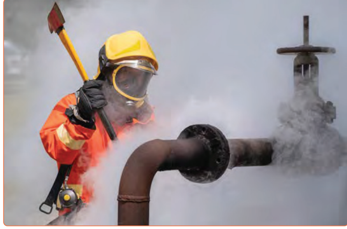
Görsel 12.3: LPG boru hattında meydana gelen sızırtı
