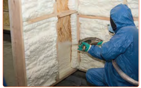
Görsel 7.9: Poliüretan ile duvar izolasyonu
