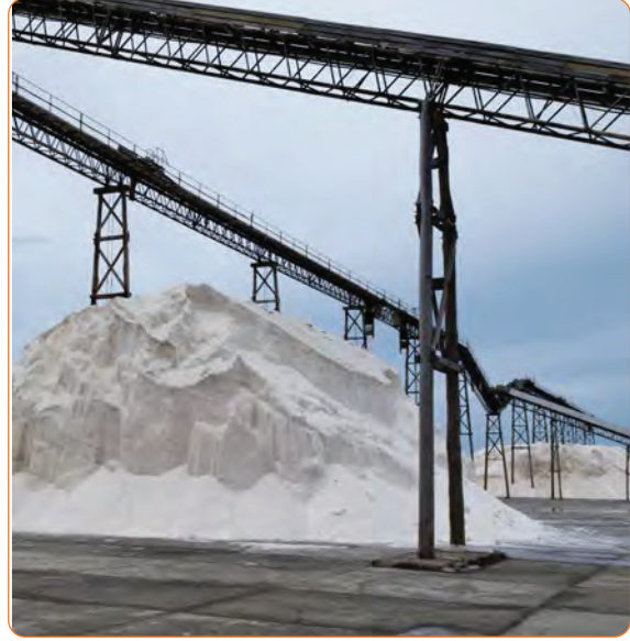
Görsel 4.2: Tuz rafineri tesisinde koveyör bandı
