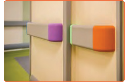
Görsel 5.13: Hastahanedeki PVC duvar kaplamaları
