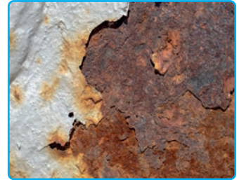
Görsel 1.23: Kabuk altı korozyonuna uğramış metal
