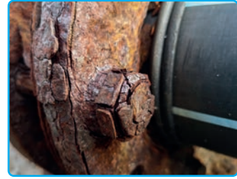
Görsel 1.26: Atmosferik korozyon örneği
