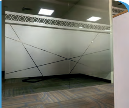
Görsel 3.6: Ofis kapısında kullanılmış buzlu cam
