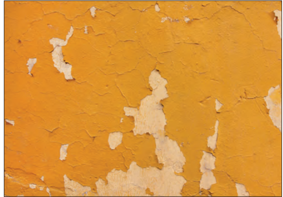
Görsel 3.12: Yapışma zayıflığı kusuruna sahip boyalı yüzey
