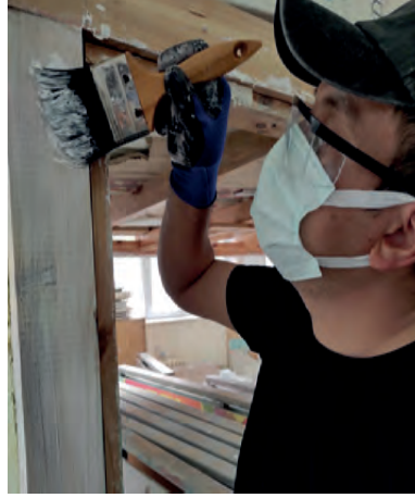
Görsel 1.56: Yüzeyin astarlanması
