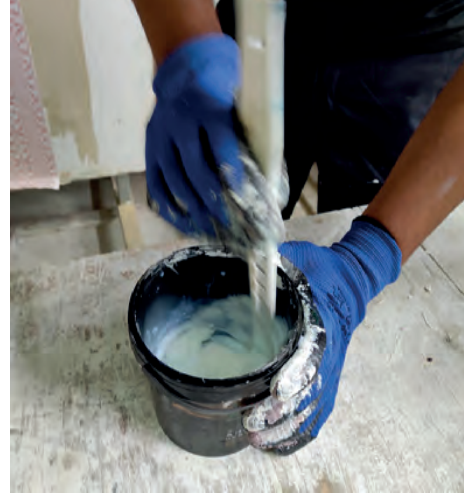
b) Su bazlı verniğin karıştırılması
