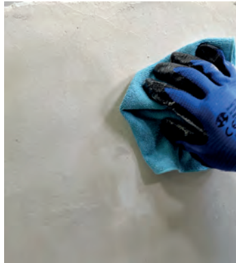
Görsel 1.46: Yüzeyin temizlenmesi
