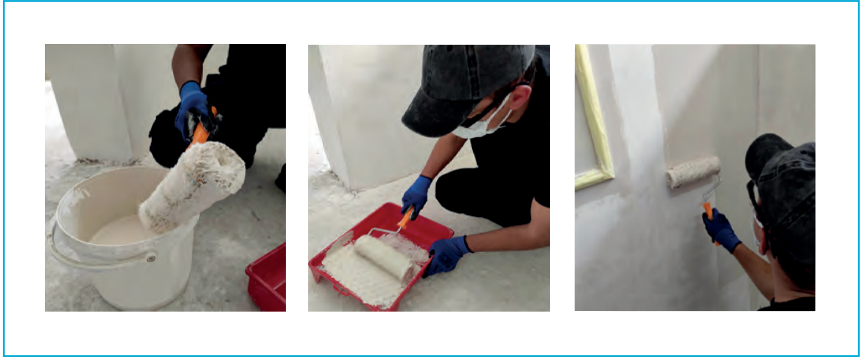
Görsel 1.50: Rulo ile yüzeyin astarlanması
