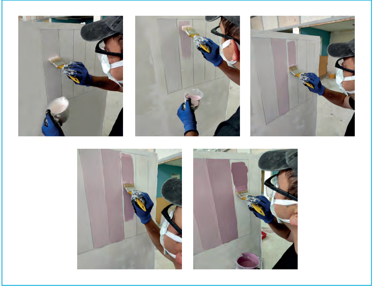
Görsel 1.40: Boyanın duvar yüzeyine renk sıralamasına göre uygulanması
