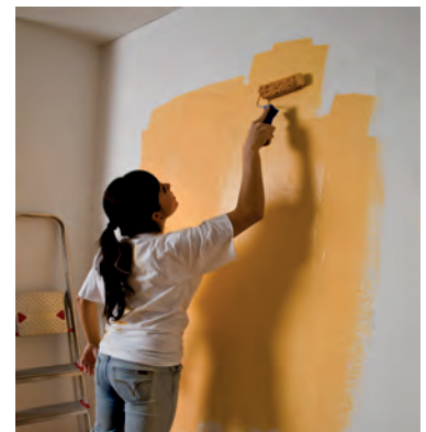
Görsel 1.6: Duvar yüzeyine rulo ile boya uygulaması
