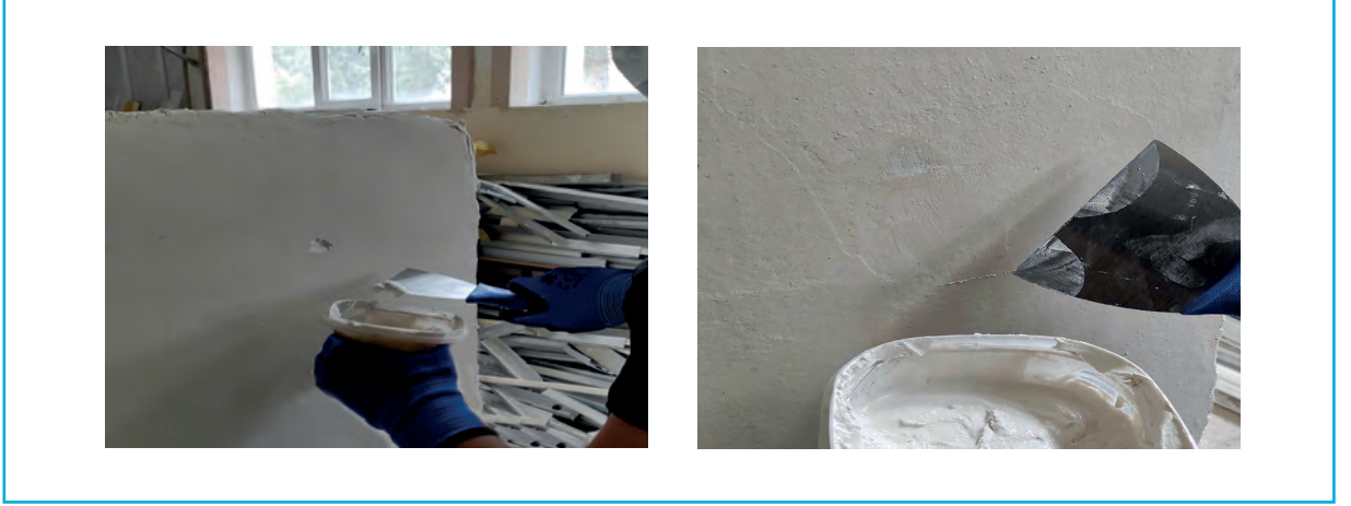
Görsel 1.44: Duvar yüzeyinde tamir işlemi
