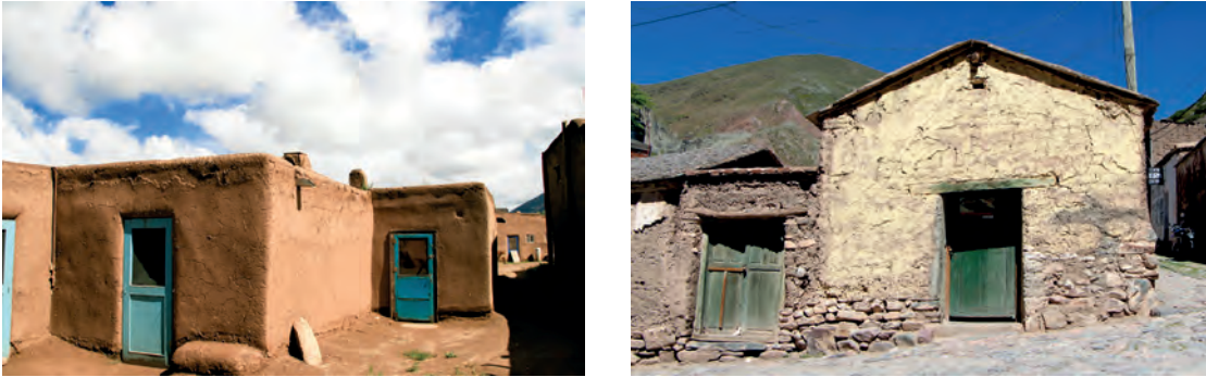
a) Çatısız yapı
