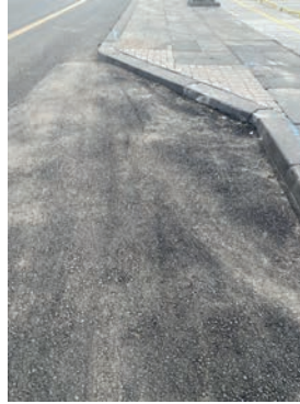
Görsel 4.19 b,c: Bordürün köşe dönüşlerinde döşenmesi
