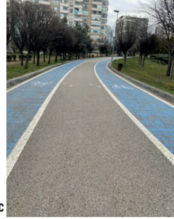
Görsel 6.2 c: Yaya ve bisiklet yolunda soğuk karışım asfalt kullanımı
