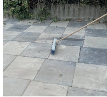
Görsel 4.30: Derzlerin doldurulması ve temizliği
