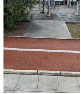
Görsel 5.20: Parklarda engelli rampası geçişi
