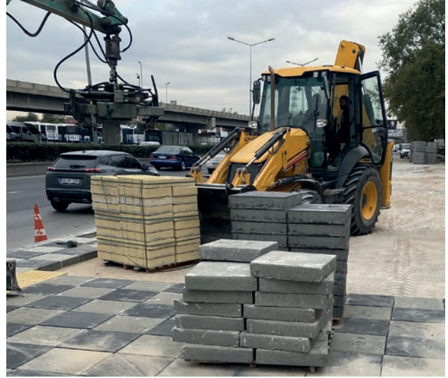
Görsel 4.10: Parke taşlarının uygulama alanına taşınması
