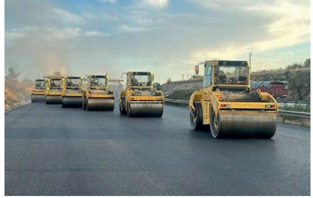
Görsel 6.1 b: Asfalt yolun silindirlerle sıkıştırılması
