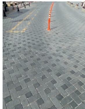
Görsel 6.4 b,c: Beton bloklarla kilitli taş kaplama
