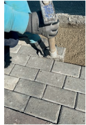
Görsel 5.12: Parke taşlarının yerine yerleştirilmesi
