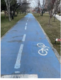
Görsel 5.3: Beton kaldırım bisiklet yolu
