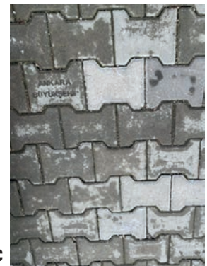
Görsel 6.4 b,c: Beton bloklarla kilitli taş kaplama
