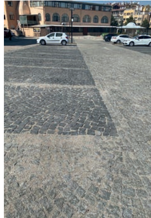
Görsel 6.3 a,b: Beton yüzey üzerine taş kaplama
