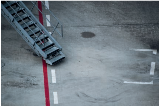
Görsel 7.1: Hava meydanında beton yüzey kaplama
