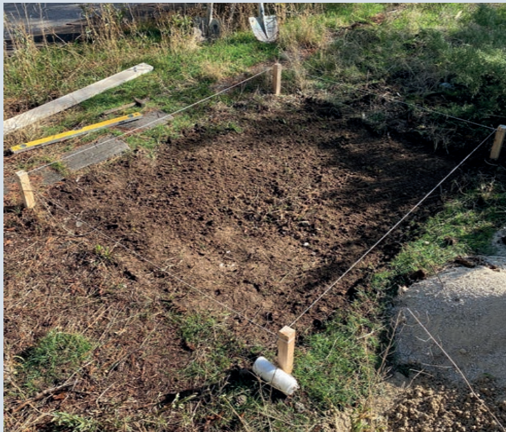
Görsel 1.5: Sıkıştırma yapılacak zemin
