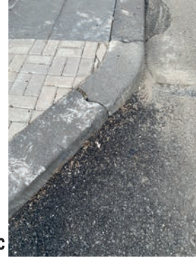
Görsel 4.19 b,c: Bordürün köşe dönüşlerinde döşenmesi
