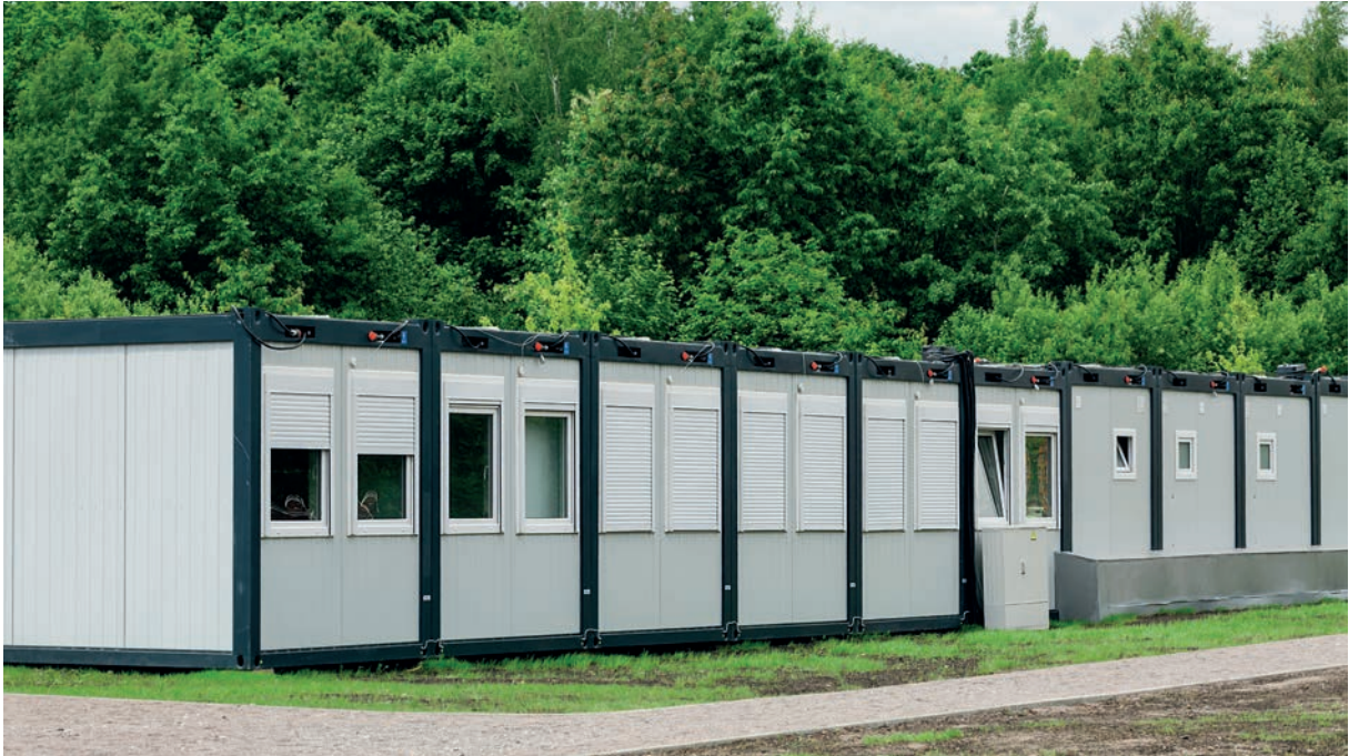
Görsel 4.8: Şantiye binası
