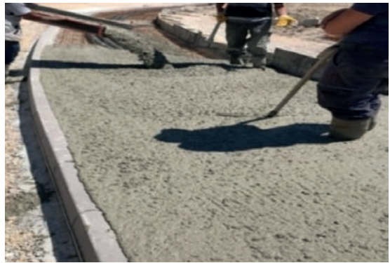
Görsel 4.16: Hasır çelik üzerine beton dökme işlemi
