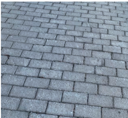
Görsel 6.4 a: Düzgün şekilli taş kaplama
