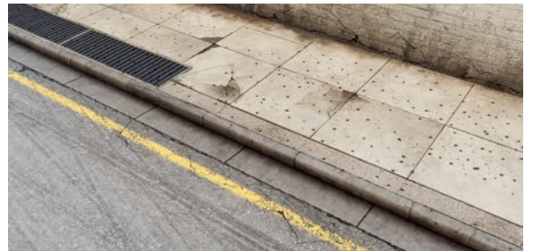
Görsel 4.28: Düşük kotlu yaya kaldırımı
