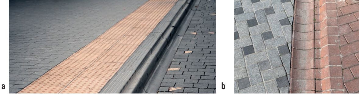
Görsel 4.33 a,b: Yol kenarında oluk taşı kaplaması
