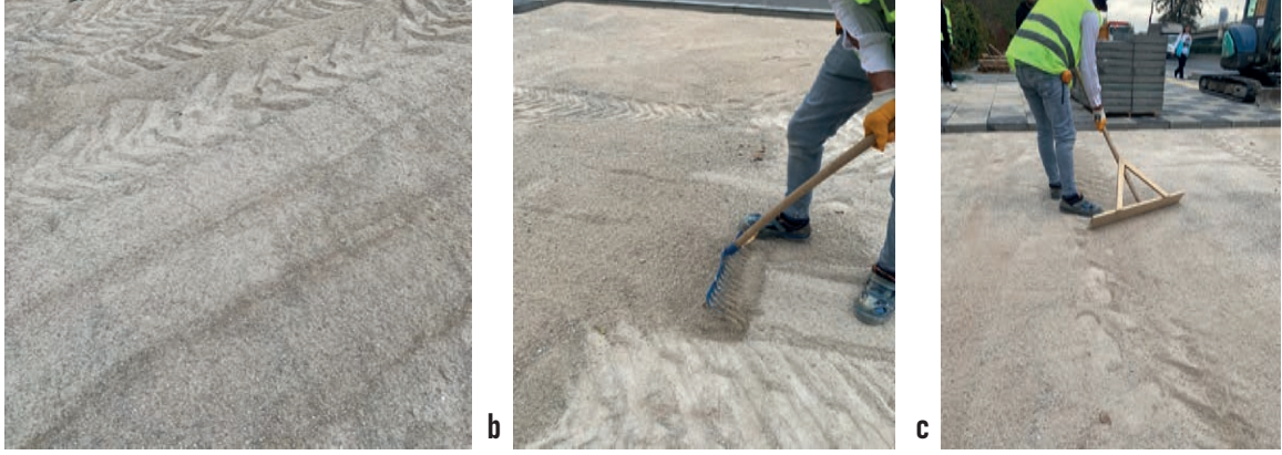
Görsel 4.14 a,b,c: Zemine agregata serme işlemi basamakları
