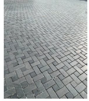
Görsel 6.9: Zikzaklı parke taşı uygulaması
