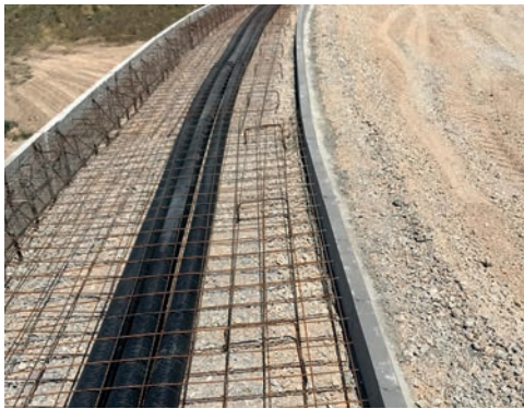
Görsel 4.15: Kılavuz boruların yerleştirilmesi
