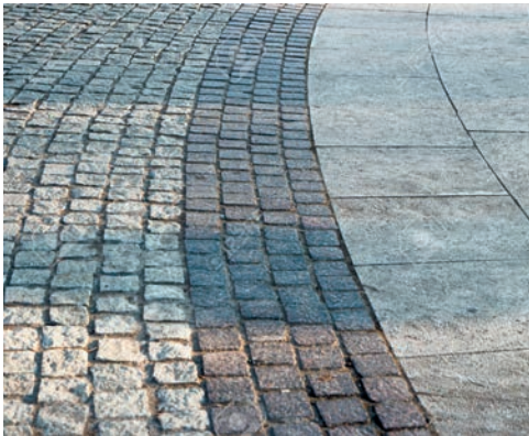
Görsel 4.17: Dönemeçlerde kaplama işlemi
