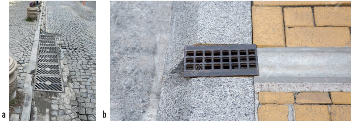
Görsel 4.34 a,b: Oluk taşını ızgaralı kanalla rögara bağlama
