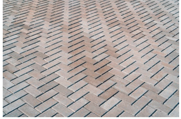
Görsel 7.7: Zikzak şeklinde kaplama
