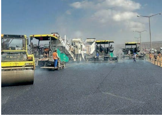
Görsel 6.1 a: Asfalt yolun finişerlerle serilmesi
