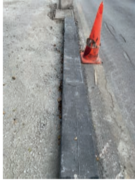
Görsel 4.19 a: Bordürün ip arasına döşenmesi
