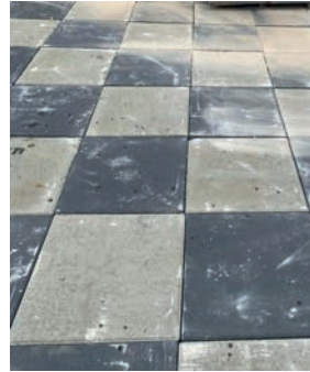
Görsel 6.12: Yüzei kaplamalı beton taşlarla kaplama
