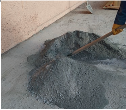
Görsel 1.35: Beton malzemelerinin kuru karıştırılması
