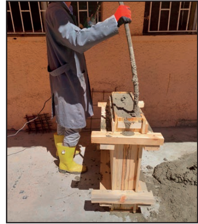
Görsel 4.13: Kalıba yerleştirilen betonun vibratörle sıkıştırılması
