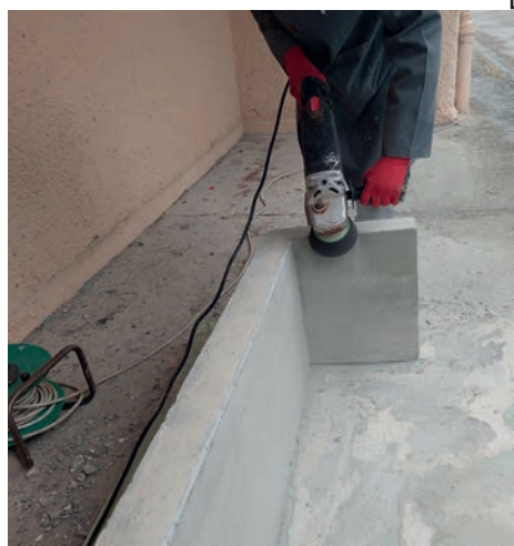
Görsel1.42: Beton bankın kenarlarının pahlandırılması
