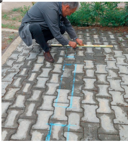
Görsel 5.22: Beton ayak yerleri markalama
