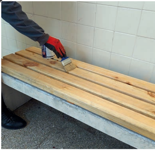
Görsel 1.10: Ahşabın fırça ile emprenye edilmesi
