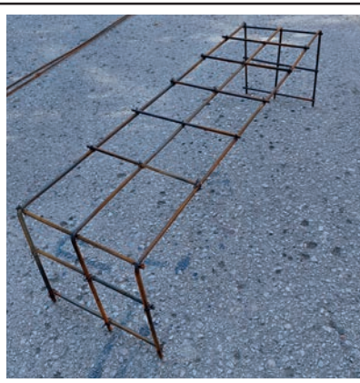
Görsel 1.32.b: Donatının bağlanmış hâli
