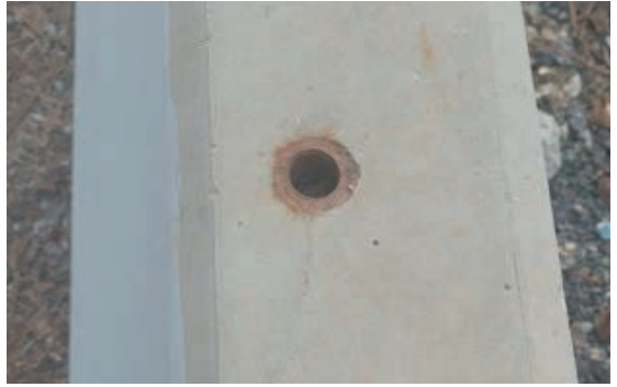
Görsel 3.21.ç: Taşıma ve montaj ankrajı
