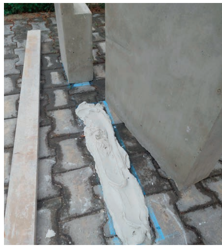
Görsel 5.25: Markalama alanına yapıştırma harcın serilmesi
