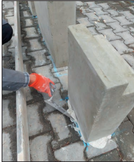
Görsel 5.28: Harç fazlalıklarının temizlenmesi
