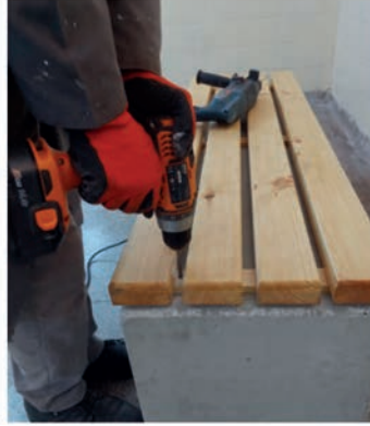
Görsel 1.50.b: Ahşap lataların beton banka bağlanması
