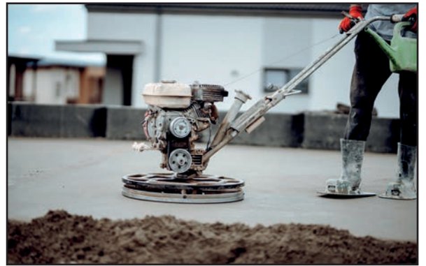
Görsel 5.7: Beton yüzeyine helikopter perdah yapılması
