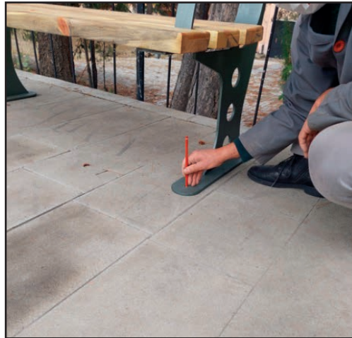
Görsel 5.18: Bank montaj noktalarının markalanması
