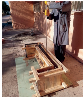
Görsel 1.38: Betonun kalıba konulup şişlenmesi
