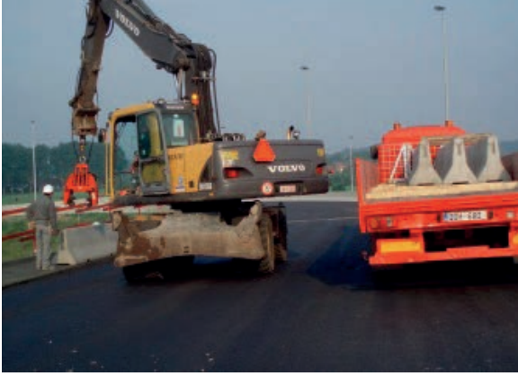
Görsel 3.26.a: Beton bariyer montajı
