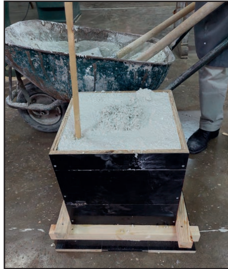
Görsel 2.17: Hazırlanan betonun kalıba yerleştirilmesi ve sıkıştırılması
