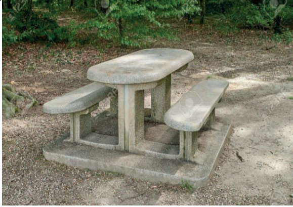
Görsel 4.4.a: Yerde dökülmüş beton piknik masası
