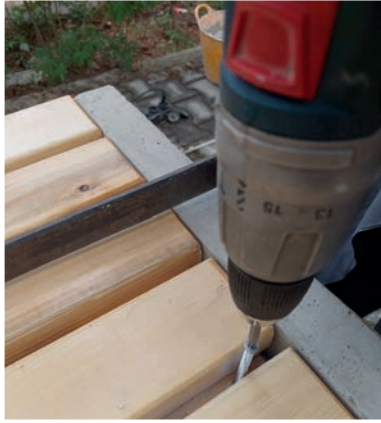
Görsel 5.30: Tork vidasının sıkılması
