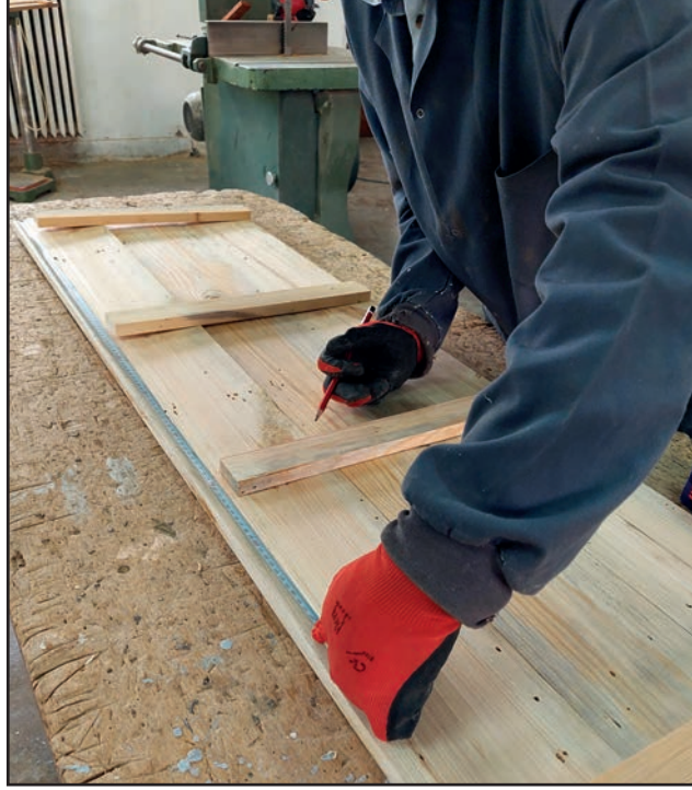
Görsel 1.20: Klape yerlerinin markalanması
