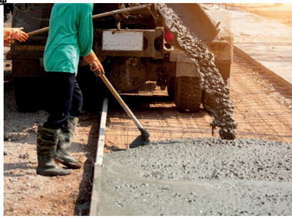
Görsel 5.8.a: Betonun ano olarak dökümü
