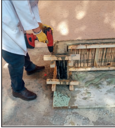
Görsel 1.40: Kalıbın sökölmesi
