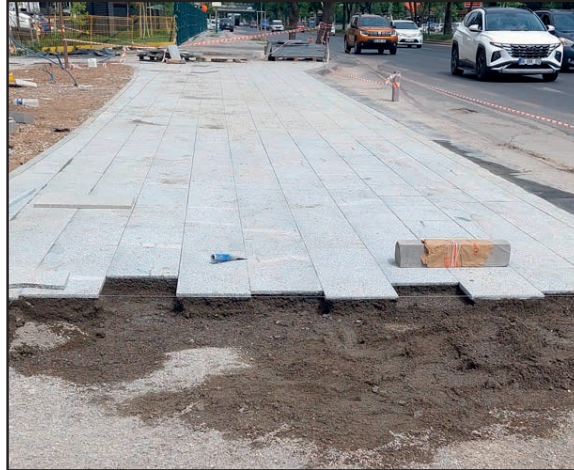
Görsel 5.10: Andezit kaplama çalışması
