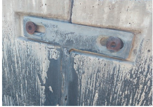
Görsel 3.26.b: Bariyer ankraj montajı
