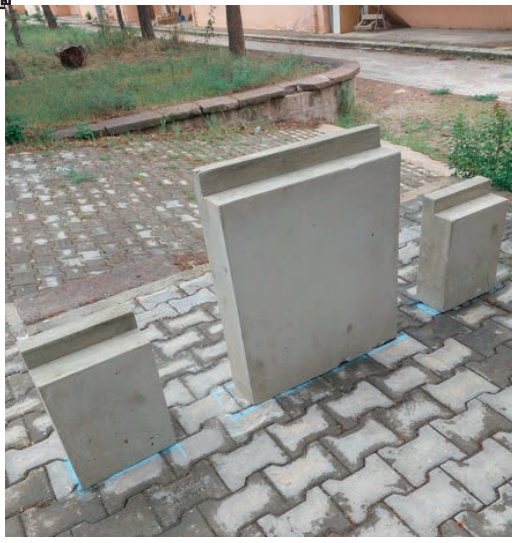
Görsel 5.26: Beton ayakların yapıştırma harcı üzerine yerleştirilmesi
