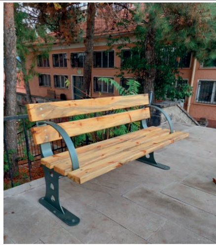
Görsel 5.21: Bankın andezit kaplı zemine bağlanmış hâli
