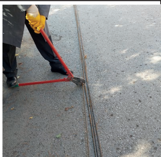
Görsel 1.27: Demir boylarının kesilmesi
