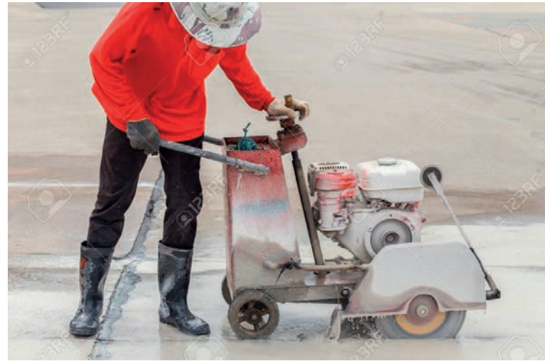
Görsel 5.8.c: Derz kesme makinesi ile beton kaplama yüzeye derz verme
