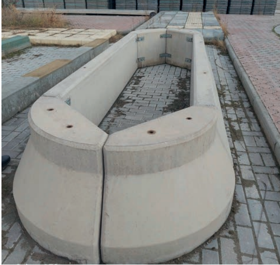
Görsel 3.26.c: Montajı yapılmış bariyerler
