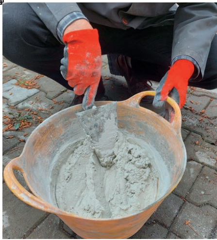
Görsel 5.24: Yapıştırma harcın hazırlanması
