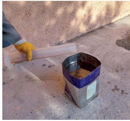
Görsel 1.36: Su ve katkı malzemesinin karıştırılması
