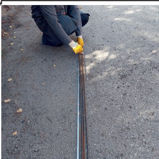
Görsel 1.26: Demir boylarının işaretlenmesi
