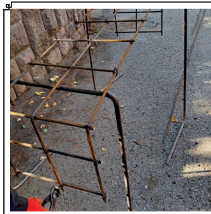
Görsel 1.32.a: Demirlerin bağ teli ile bağlanması
