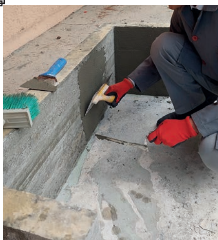
Görsel 1.41: Beton bankın hatalı kısımlarının tamir edilmesi
