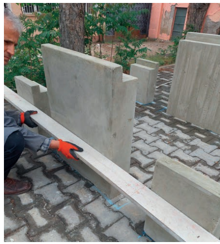
Görsel 5.23: Beton ayakların doğrultularının kontrol edilmesi
