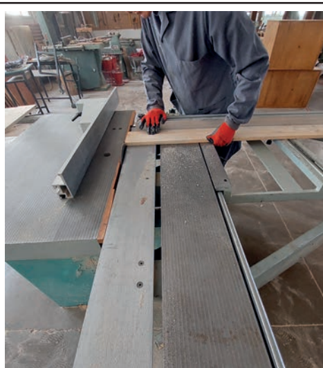
Görsel 1.19.b: Kalıp tahtalarını boyuna ebatlama
