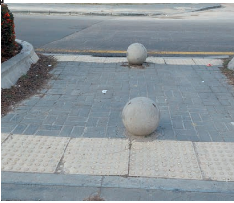
Görsel 3.10.a: Refüj yaya geçidindeki mantar uygulaması
