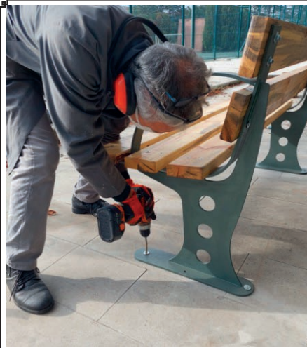
Görsel 5.20: Tork vidasının sıkılması
