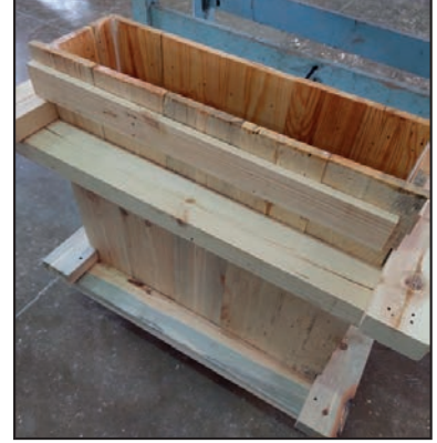
Görsel 4.11: Beton ayak kalıbının bitmiş ve yağlanmış hâli
