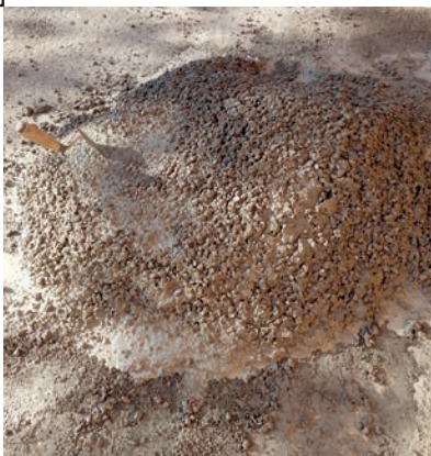
Görsel 1.37: Betonun homojen olarak karıştırılması
