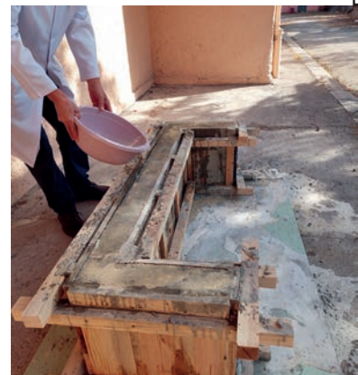
Görsel 1.39: Betonun sulanması
