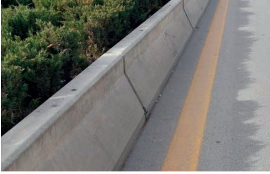
Görsel 3.1.a: Beton bariyer
