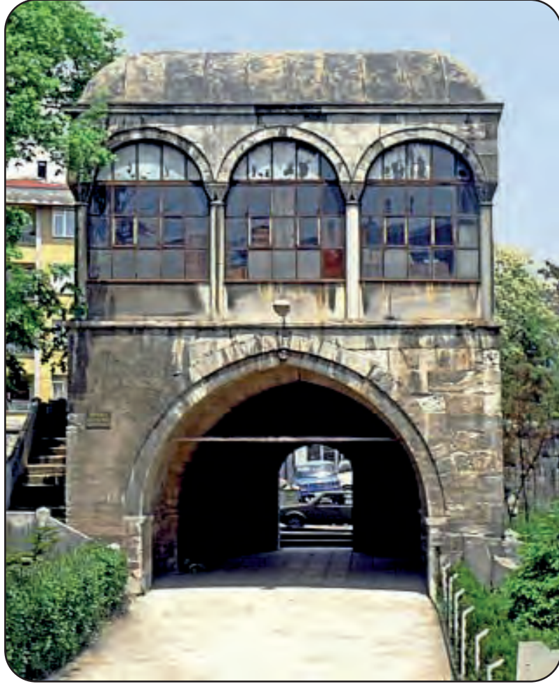
Görsel 2.50: Tonozlu geçiş
