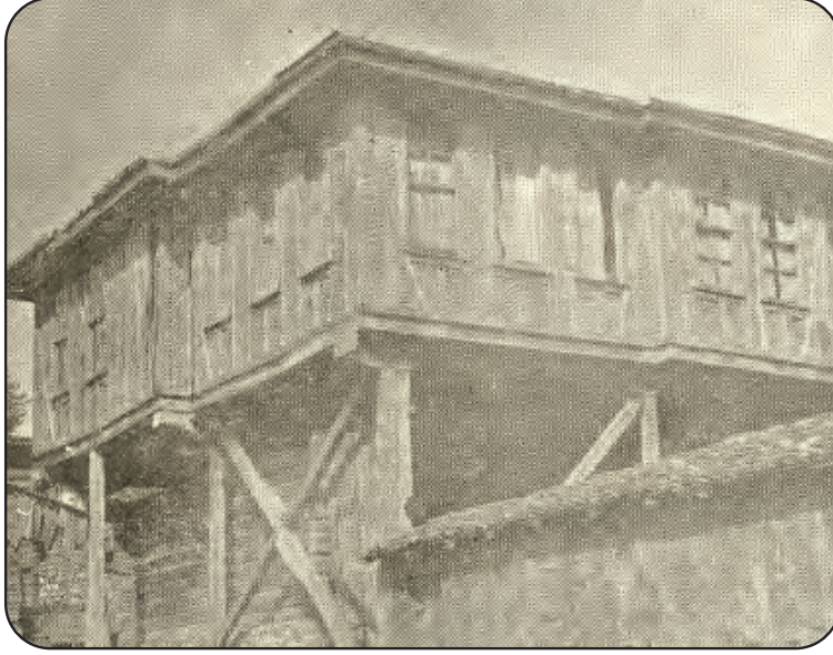
Görsel 2.19: Münferit taş temeller üzerine oturtulmuş ahşap ev
