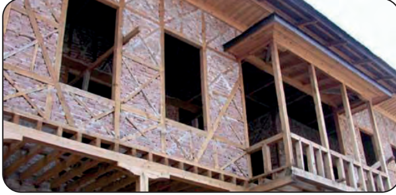
Görsel 2.6: Ahşap iskelet yapı
