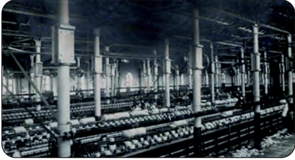
Görsel 2.8: Feshane binası iç mekânı ve çelik taşıyıcı sistemi
