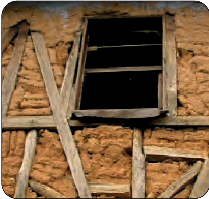
Görsel 2.26: Kerpiç dolgu duvar
