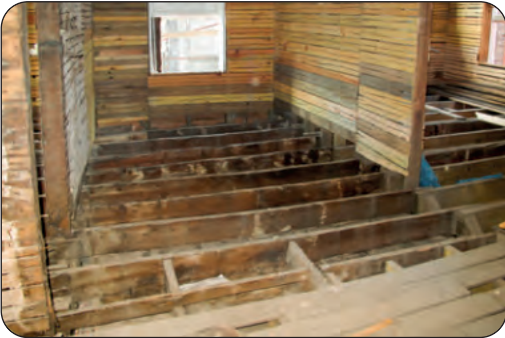
Görsel 2.59: Yerinde korunan özgün ahşap döşeme kirişleri-2
