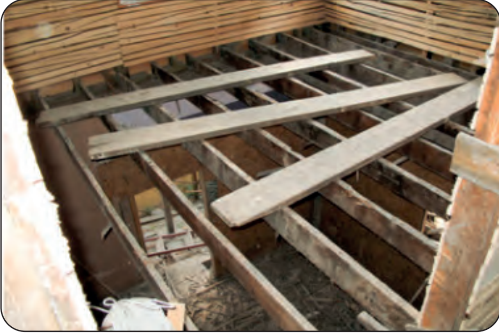
Görsel 2.58: Yerinde korunan özgün ahşap döşeme kirişleri-1
