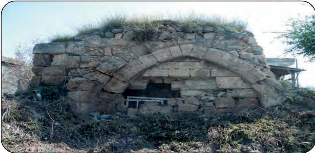
Görsel 2.49: Tonozlu yapı (Adana)
