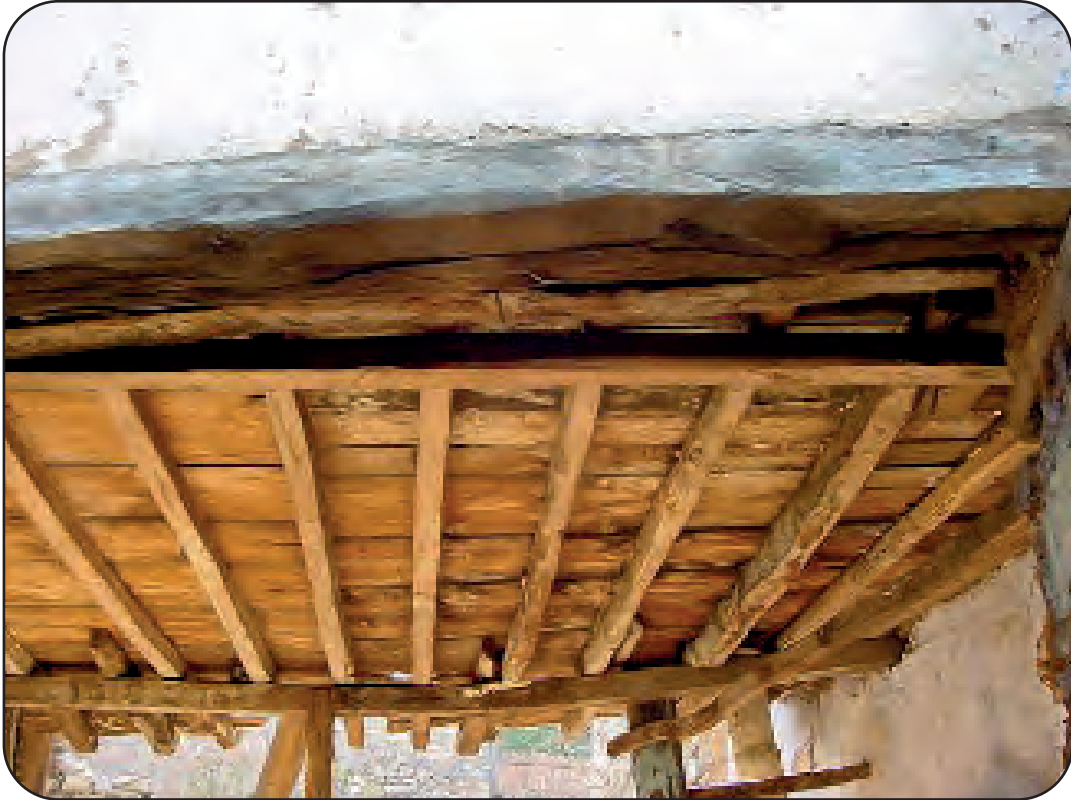
Görsel 2.31: Cumalıkızık Evleri'nde ahşap döşeme
