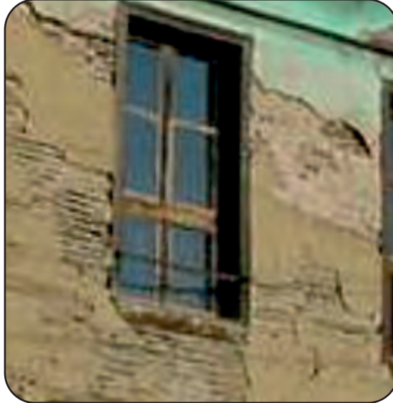
Görsel 2.28: Bağdadi sıva kaplama duvar
