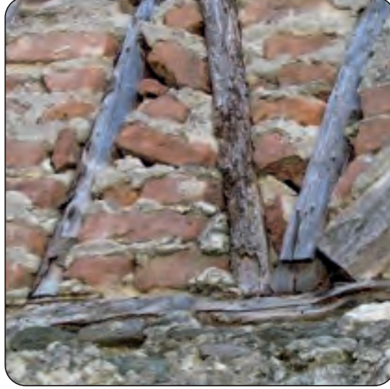
Görsel 2.27: Tuğla dolgu duvar
