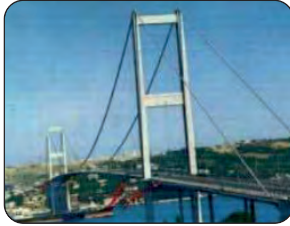
Görsel 2.42: 15 Temmuz Şehitler Köprüsü
