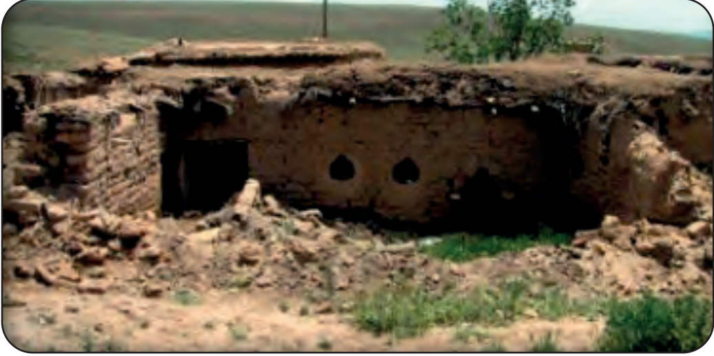
Görsel 2.4: Kerpiç yiğma yapı
