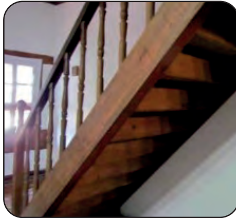
Görsel 2.63: Geleneksel Anadolu yapılarında ahşap merdiven
