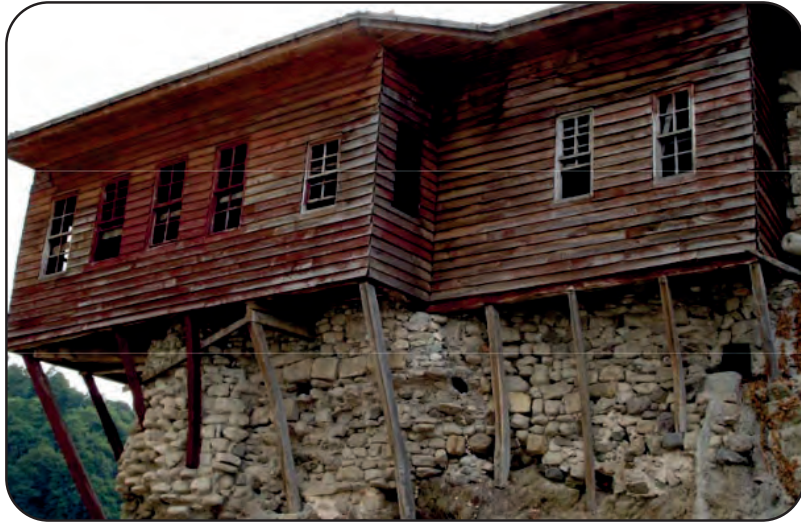
Görsel 2.18: Kâgir taş temeller üzerine oturtulmuş ahşap ev
