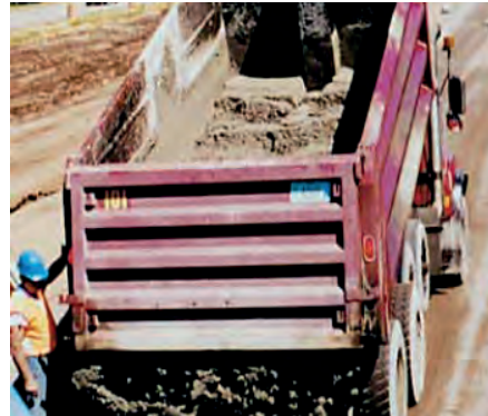
Görsel 3.9: Üstü açık kamyonla beton dökme
