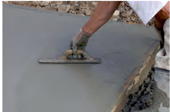
Görsel 2.31: Perdah ile beton yüzeyini düzeltme işlemi
