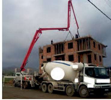
Görsel 3.5: Beton pompası ile beton dökümü
