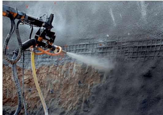
Görsel 2.5: Püskürtme beton
