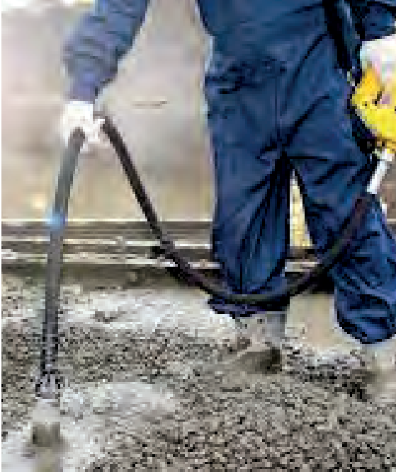
Görsel 2.24: Vibratör ucunun betona dik daldırılması işlemi
