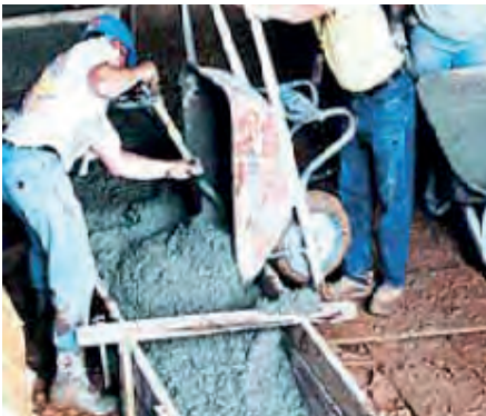
Görsel 3.8: El arabası ile beton dökme
