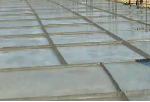
Görsel 2.35: Göllendirme yöntemi ile beton kürü
