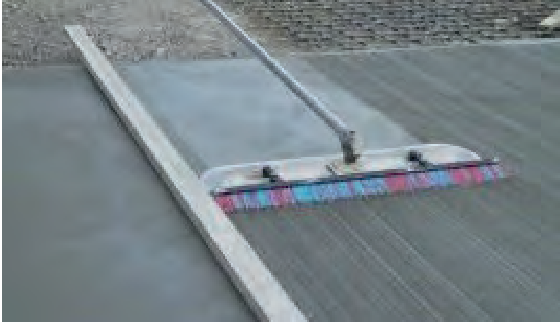
Görsel 2.29: Beton yüzeyini süpürme yöntemi ile pürüzlendirme işlemi
