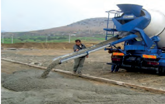
Görsel 3.6: Transmikser ile beton dökme
