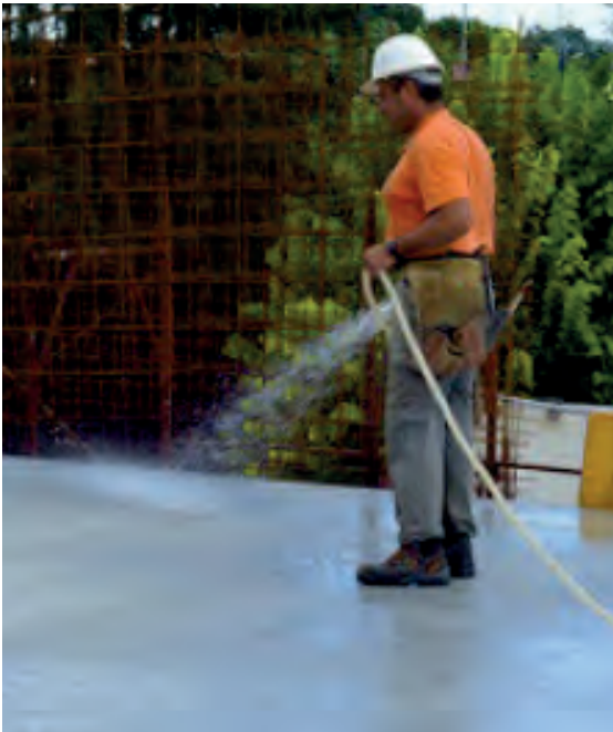
Görsel 2.34: Su püskürtme yöntemi ile beton kürü
