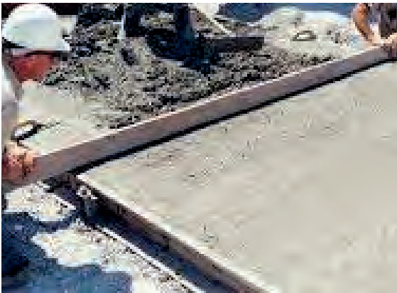
Görsel 2.30: Mastar ile beton yüzeyini düzeltme işlemi
