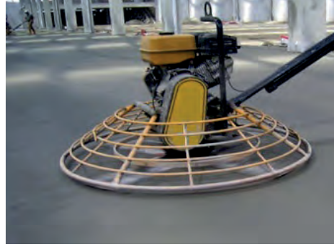
Görsel 2.33: Perdah makinesi ile beton yüzeyini düzeltme işlemi
