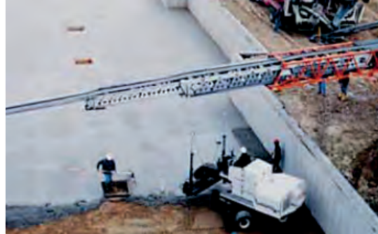
Görsel 3.7: Taşıyıcı bant ile beton dökme
