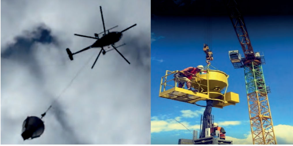
Görsel 3.10: Helikopter veya kule vinç yardımıyla betonu kovalarla taşıyarak dökme
