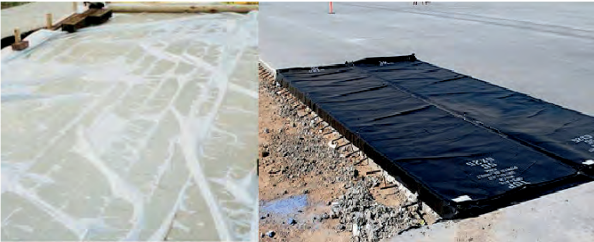
Görsel 2.37: Beton yüzeyini örtülerle örtme yöntemi ile beton kürü
