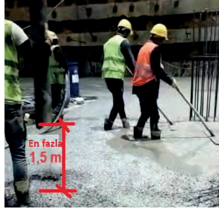
Görsel 2.15: Pompa ucu ile kalıp arası mesafe
