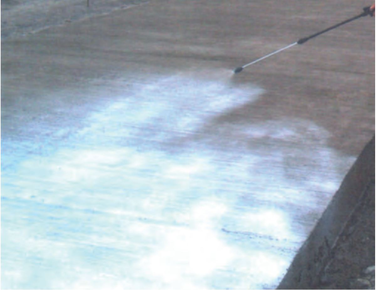
Görsel 2.38: Kimyasal kür maddeleri ile beton kürü
