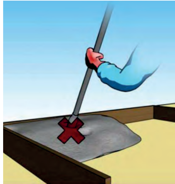
Görsel 2.27: Vibratör ucu ile betonu taşıma
