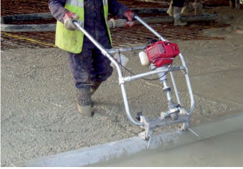
Görsel 2.32: Titreşimli master ile beton yüzeyini düzeltme işlemi
