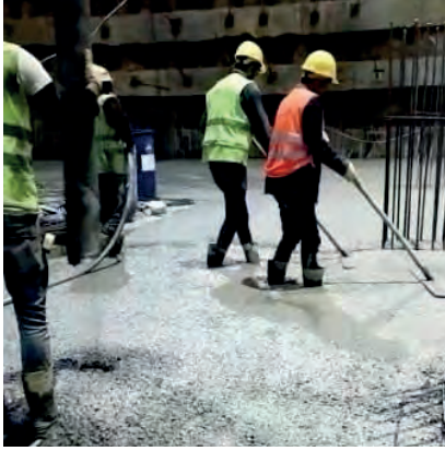
Görsel 2.14: Betonun düşey yönde dökülmesi
