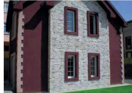
Görsel 10.29: Yapay taş kaplama yapılmış bina
