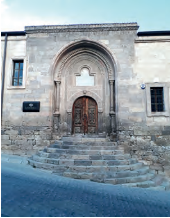
Resim 6.38: Makine ile ön cephe çekim
