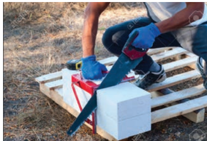
Görsel 2.4: Gaz betonun kesilmesi
