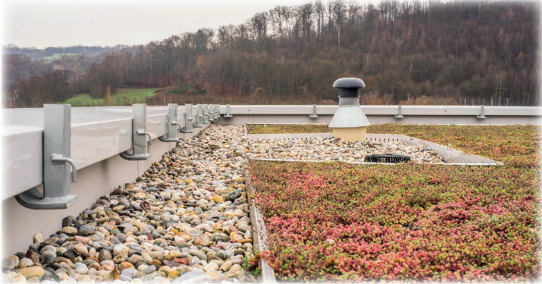
Görsel 7.10: Üzerinde gezilmeyen teras çatı
