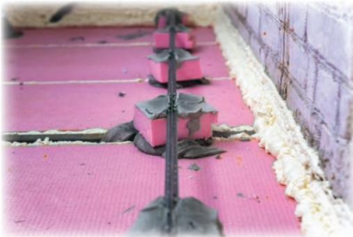
Görsel 7.2: Isı yalıtım levhası ile ısı yalıtımı
