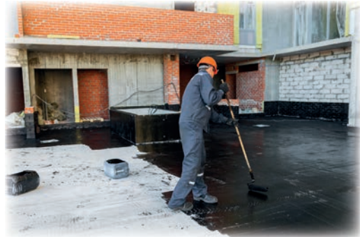
Görsel 7.3: Sürme esaslı malzeme ile su yalıtımı
