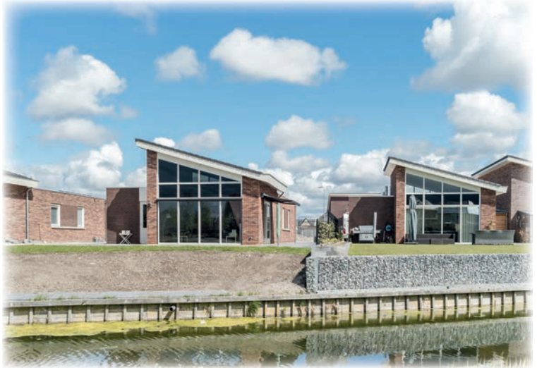
Görsel 4.1.b: Betonarme çatı
