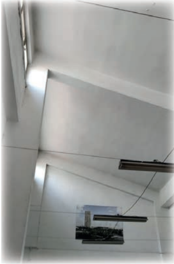
Görsel 4.1.a: Betonarme çatı
