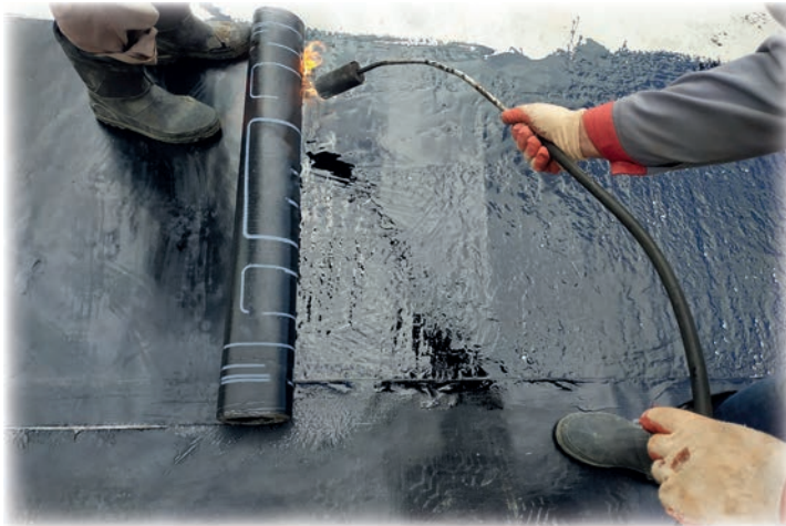
Görsel 6.3: Çatılarda bitümlü membran ile su yalıtımı
