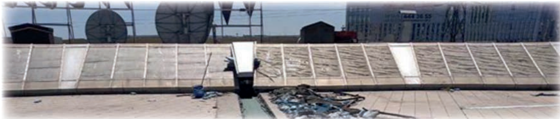
Görsel 8.28: Çatı örtüsü bölgesindeki boşlukların kapatılması
