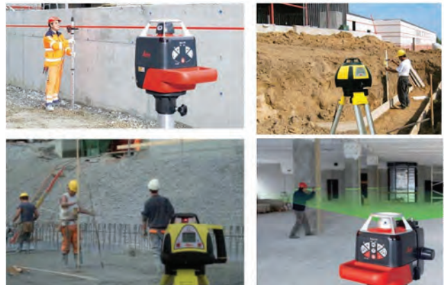
Görsel 5.33: Lazer nivelonun inşaatındaki kullanımı
