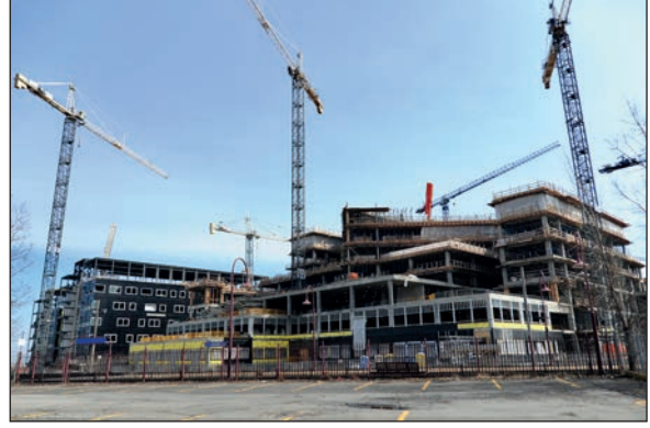
Görsel 3.12: Hastane inşaatı
