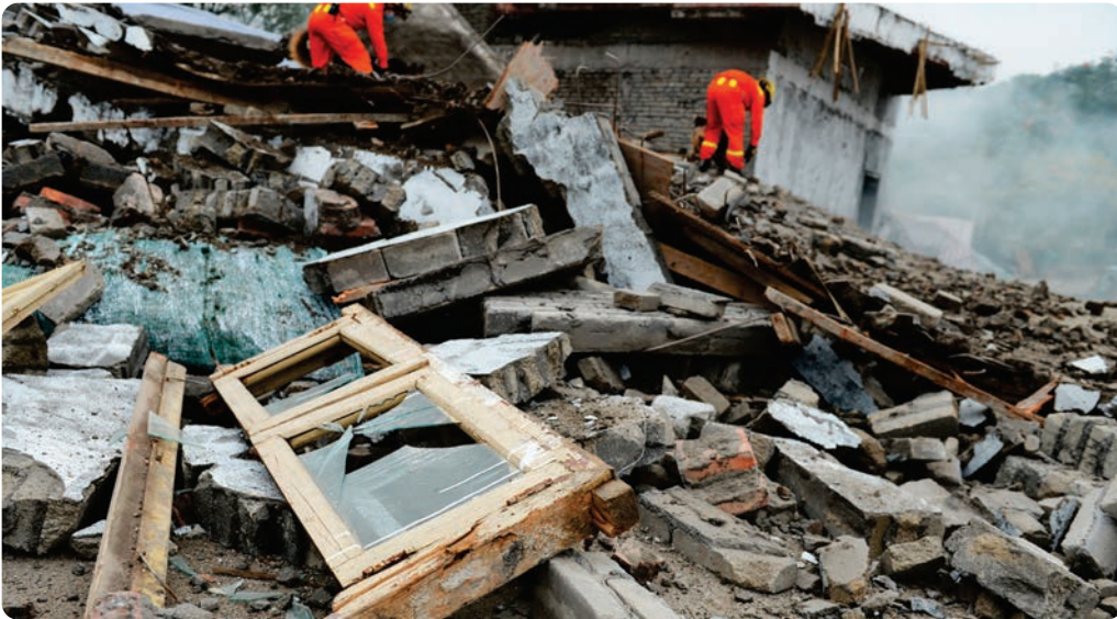
Görsel 2.3: Deprem sonrası arama kurtarma çalışmaları
