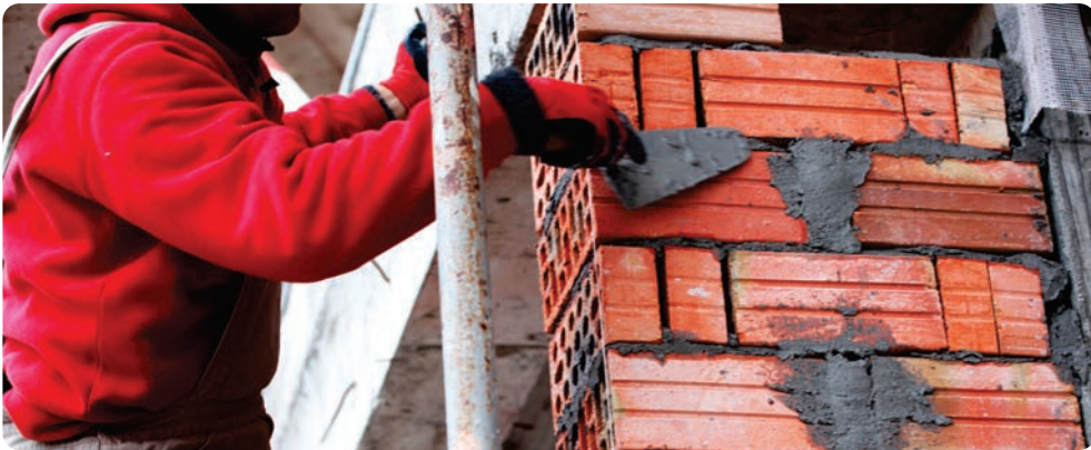
Görsel 3.9: Dayanıklı bina uygulaması
