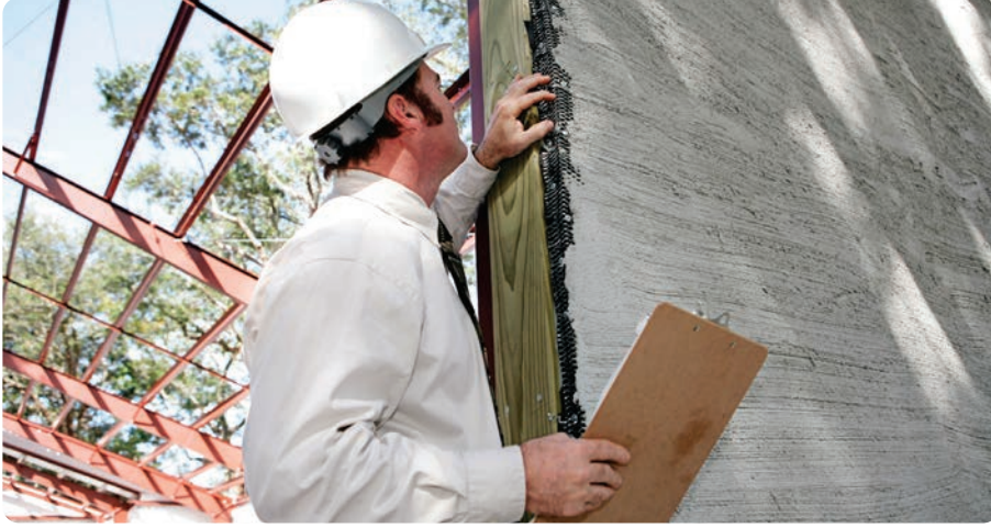
Görsel 5.3: Deprem öncesinde güçlendirme çalışması
