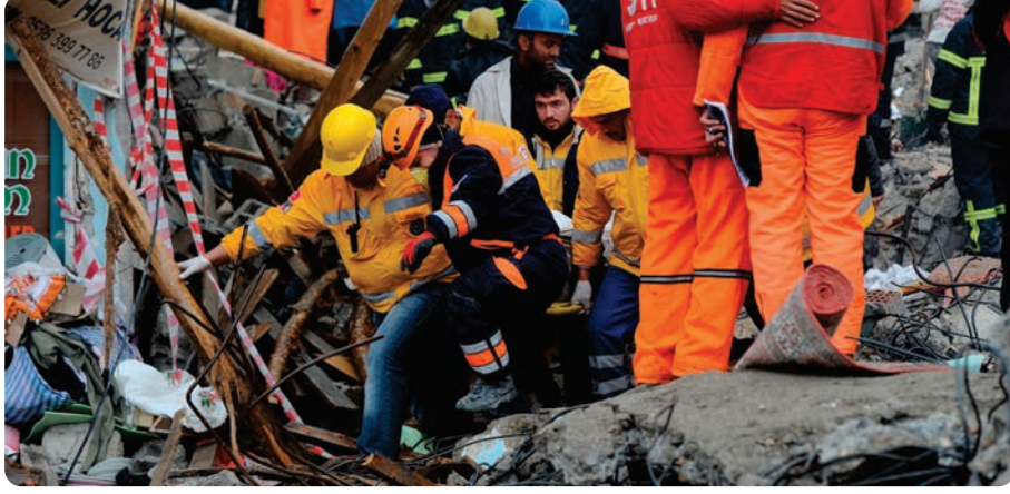
Görsel 1.6: Deprem sonrası kurtarma çalışması
