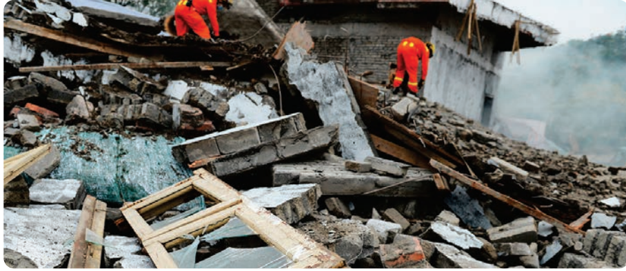
Görsel 1.7: Afet sonrası yıkımlar
