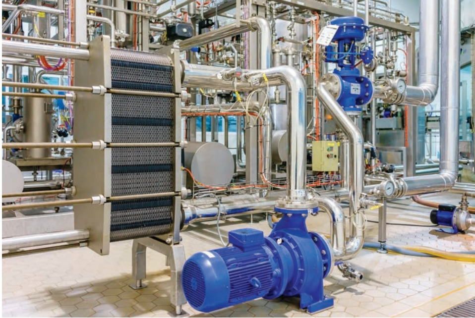
Görsel 1.14: Süt işletmesinde taşıyıcı sistemde pompanın kullanımı
