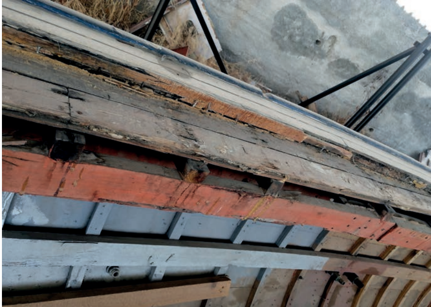
Görsel 1.14: Kemerelerin açığa çıkarılması
