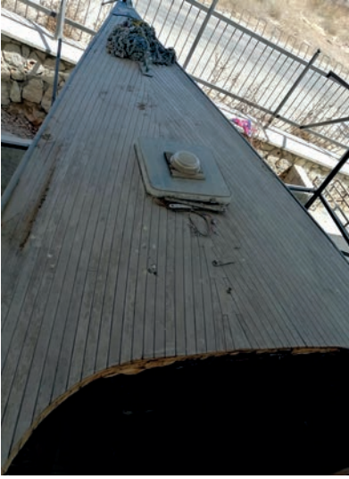
Görsel 4.3: Yenilenecek güverte kaplaması
