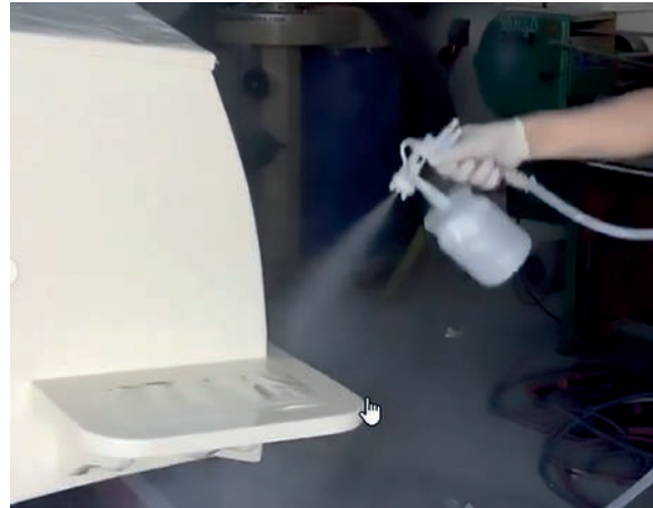
Görsel 5.2: Astar boyanın püskürtme yöntemiyle uygulanması
