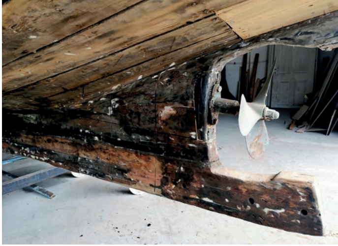
Görsel 1.11: Omurga ve pervane yatağının açığa çıkarılması
