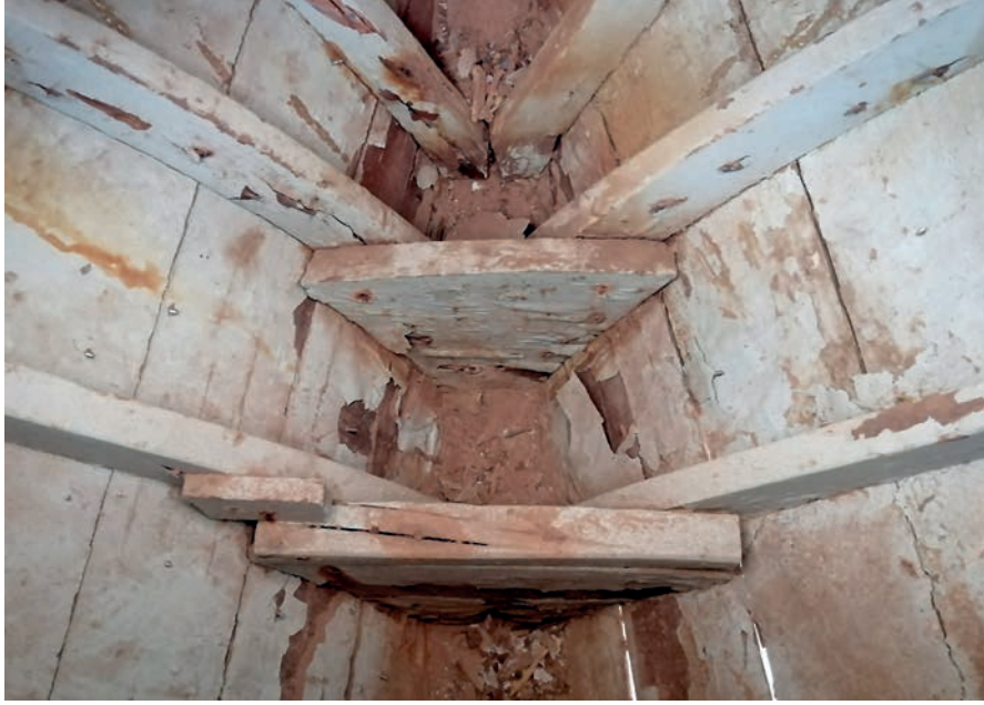
Görsel 1.13: Döşeklerin açığa çıkarılması
