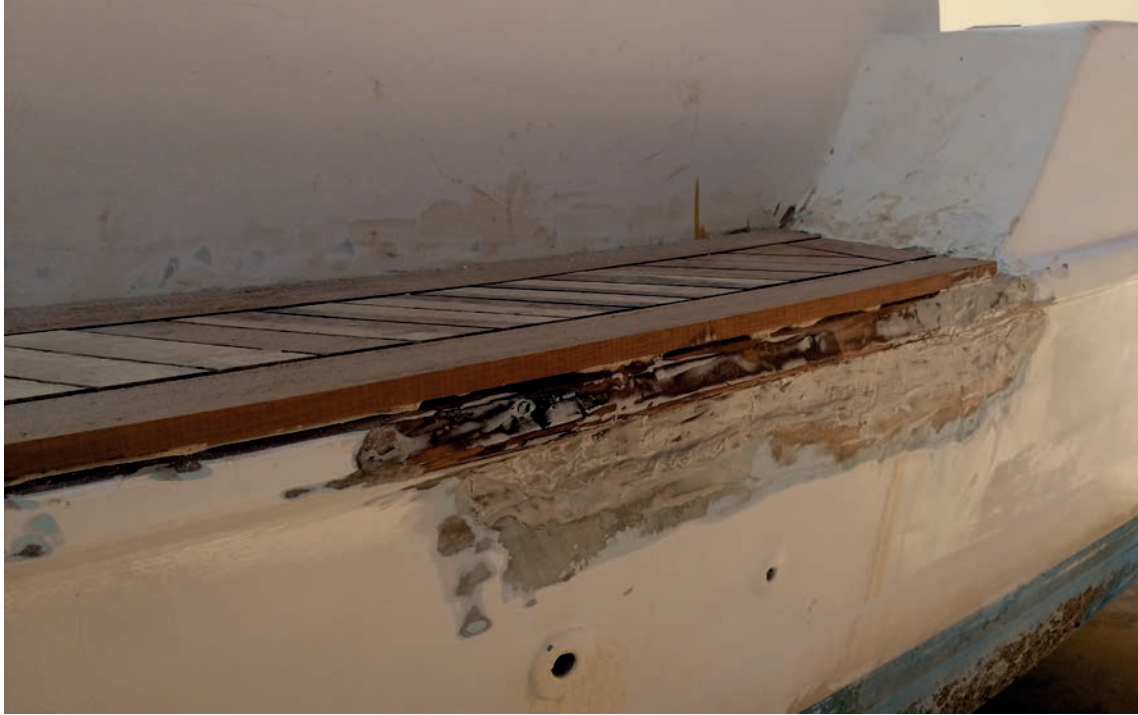
Görsel 1.15: Yenilenecek bölgenin onarımı
