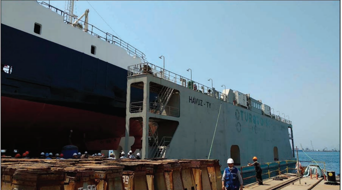
Görsel 1.32: Takaryalar üzerinde geminin oluşturulması
