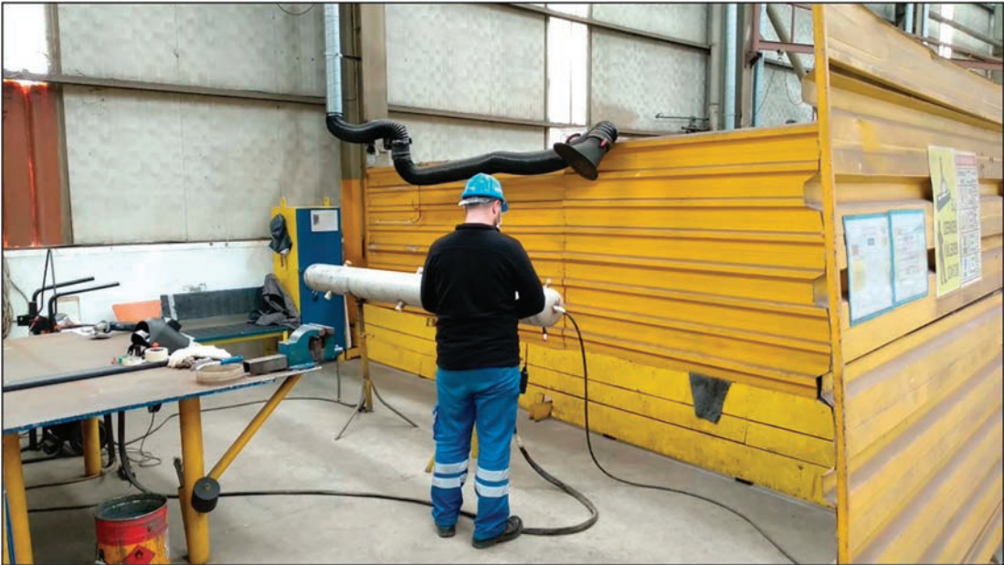
Görsel 1.24: Boruların hidrostatik ve pnömatik test işlemi
