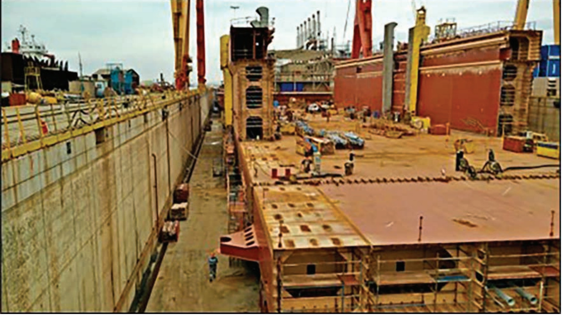
Görsel 1.31: Takaryalar üzerinde blokların birleştirilmesi
