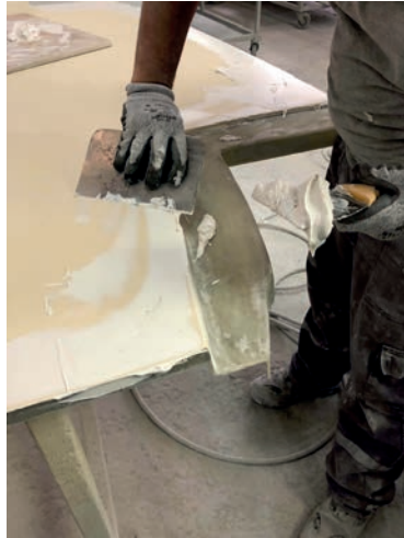
Görsel 10.11: Macun uygulaması
