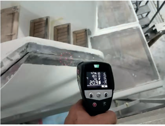
Görsel 9.9: Macun uygulanacak yüzeylerin sıcaklık kontrolü
