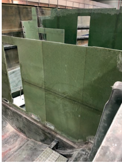
Görsel 5.26: Cam elyaf takviyeli sandviç panel imalatı ve montajı
