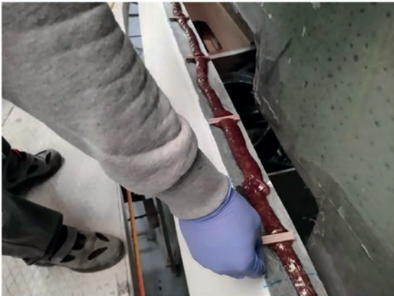
Görsel 9.17: Macun arasında kontrplak parçaların yerleştirilmesi
