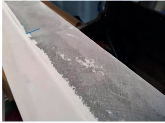
Görsel 9.10: Macunlanacak yüzeyin çapraz zımparalanması
