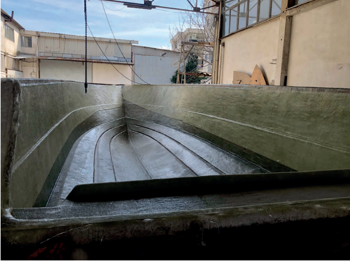
Görsel 7.2: El yatırması yöntemiyle yapılan kalıp imalatı
