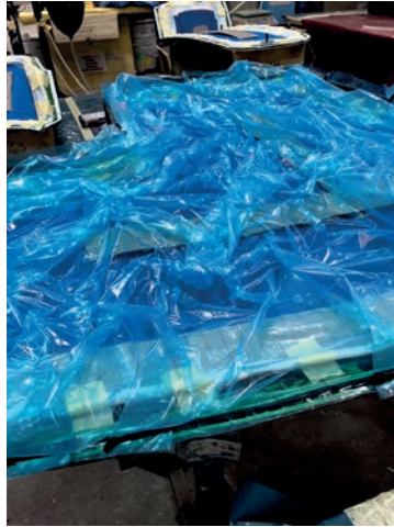
Görsel 6.17: Sistemin vakum torbası ile kapatılması
