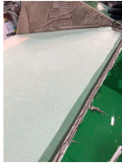
Görsel 5.12: Köpük malzemesine pah kırma
