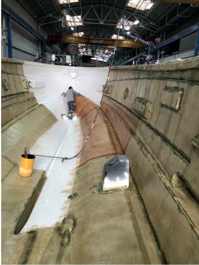
Görsel 3.16: Uygulama esnasında jelkot kontrolü
