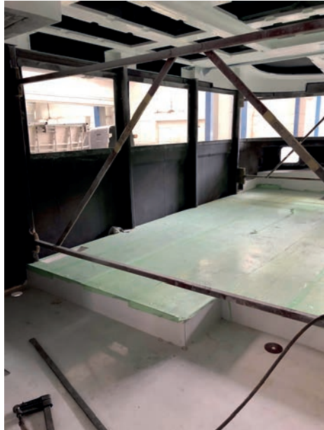
Görsel 9.8: Güverte ve havuzluk montajı
