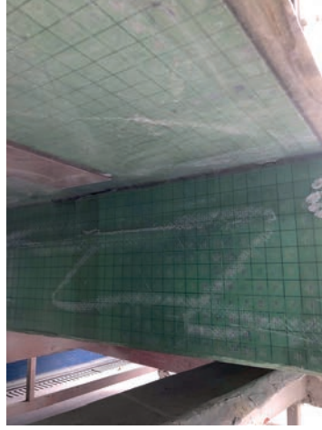
Görsel 5.19: Cam elyaf ile imal edilmiş sandviç panel
