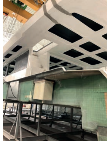
Görsel 9.24: Üst bina, güverte ve havuzluk montajı
