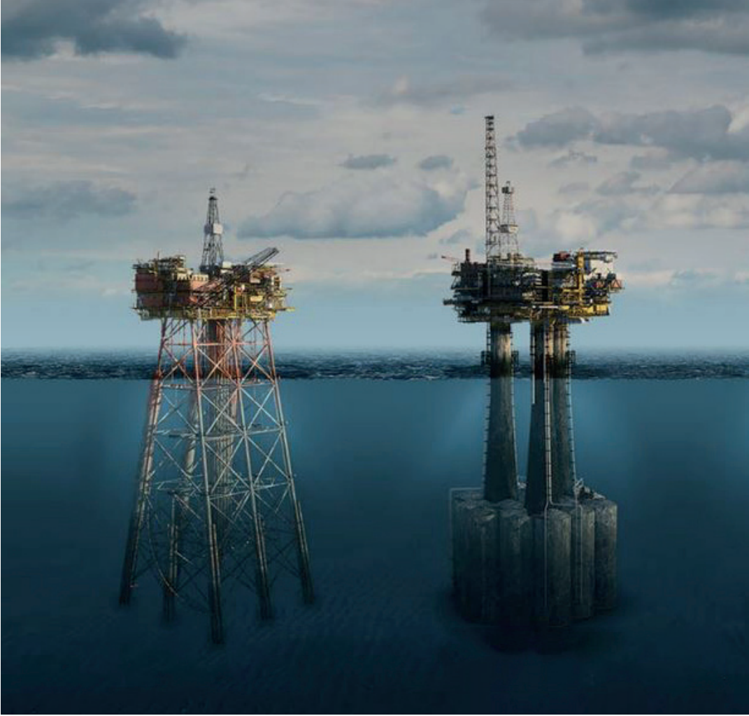
Görsel 7.3: Çelik ve beton tabanlı sondaj kuleleri
