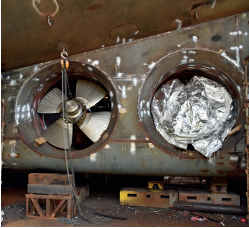
Görsel 5.13: Buzkıran tünelleri montaj aşaması
