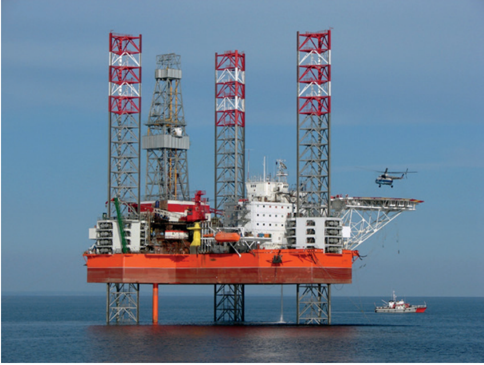
Görsel 7.4: Açık deniz sondaj platformu
