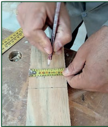
Görsel 2.26: İş parçasının işaretlenmesi
