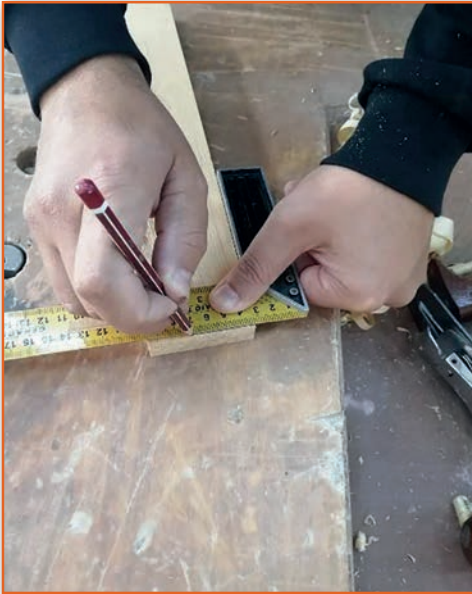
Görsel 3.37: İş parçasının ilk alın kısmının işaretlenmesi
