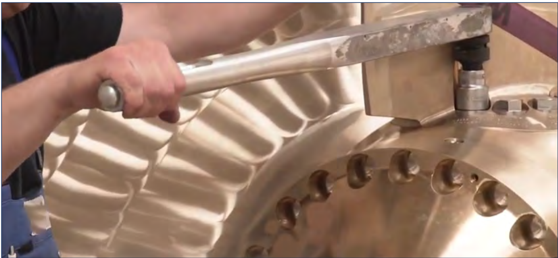
Görsel 2.44: Pervane kanadı cıvataların sıkılaştırılması
