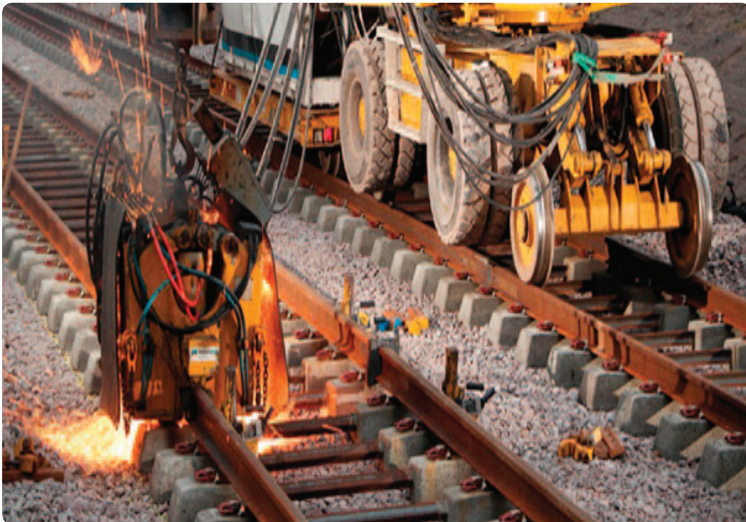
Görsel 2.3: Flaş kaynak makinesi ile tren rayına alın kaynağı
