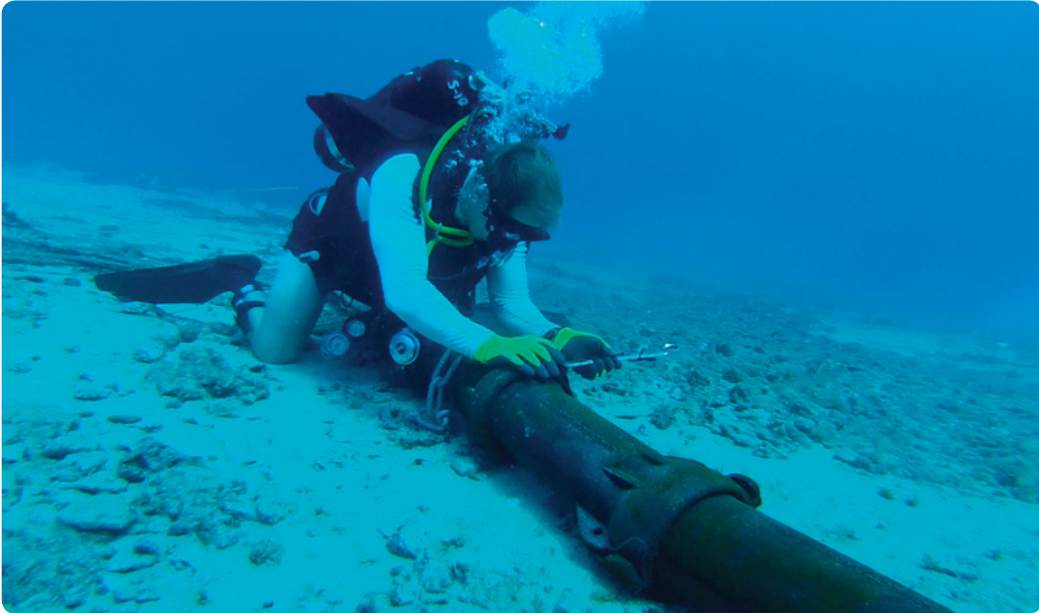
Görsel 1.10: Su altında yapılan montaj uygulaması
