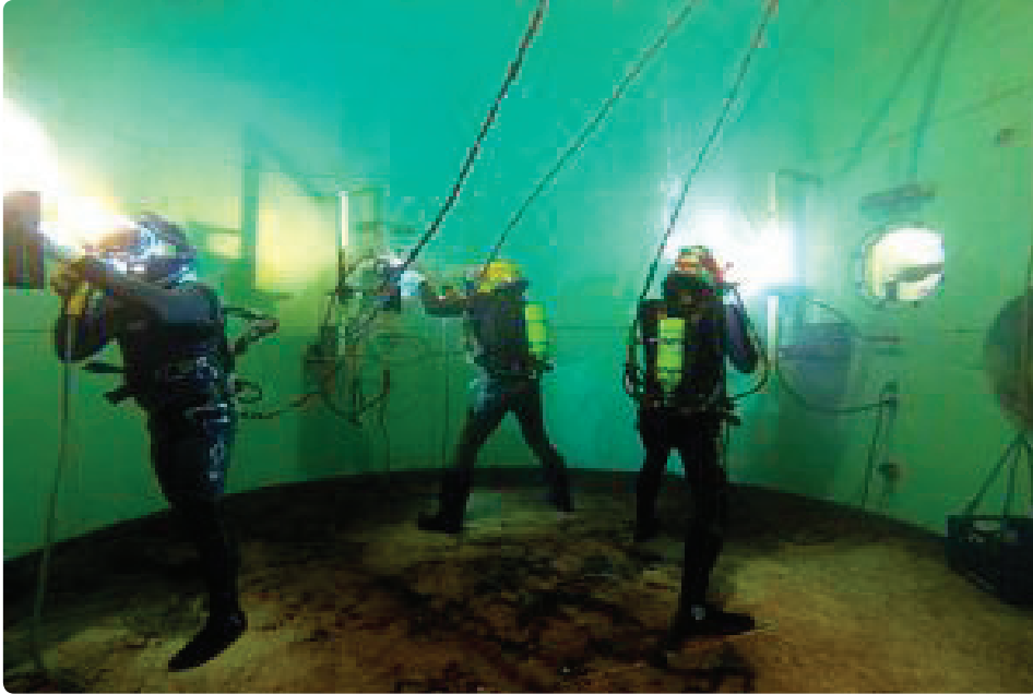
Görsel 1.2: Su altında kaynak yapan su altı kaynakçıları
