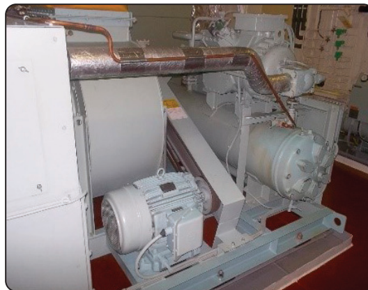
Görsel 2.49: Buzluk kompresörü borularının izolasyonu
