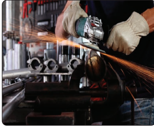
Görsel 1.10: Borunun temizlenmesi
