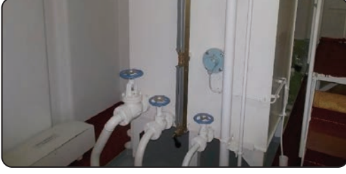
Görsel 2.28: Genişleme tank bağlantıları
