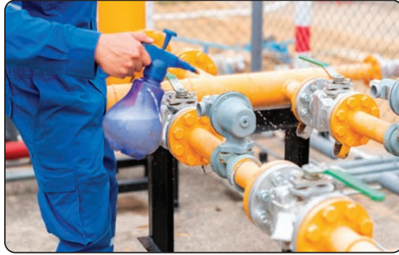
Görsel 1.50: Bağlantı noktalarına köpük uygulaması
