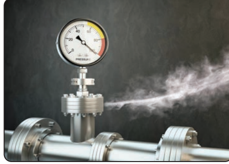
Görsel 5.11: Yüksek basınçta devrede oluşan kaçak
