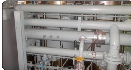
Görsel 2.27: Ana makine yağlama devresi bağlantıları
