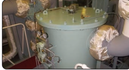
Görsel 2.26: Termostatik valf ve filtre montajı
