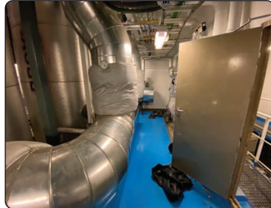
Görsel 2.48: Egzoz borularının izolasyonu
