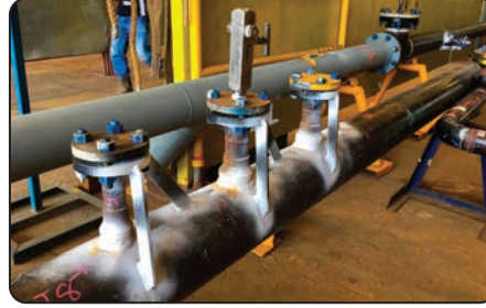
Görsel 2.10: Kaynak bağlantılarının penetrant testi
