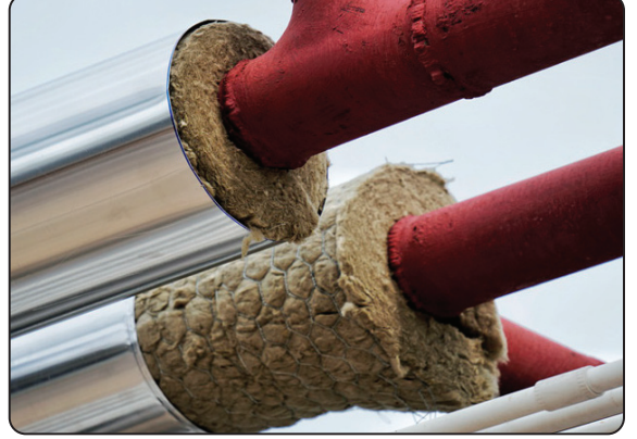
Görsel 2.51: Taş yünü uygulaması
