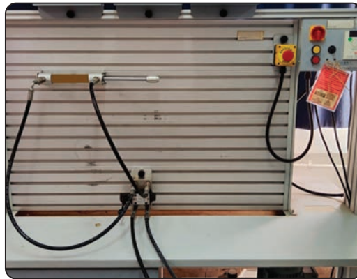
Görsel 3.24: Kurulumu yapılmış hidrolik devre
