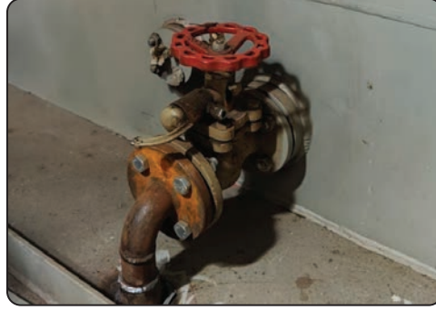
Görsel 1.25: Valfin tank ile bağlantısı
