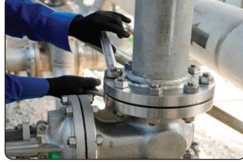
Görsel 1.24: Valfin flanşlı boruya bağlantısı
