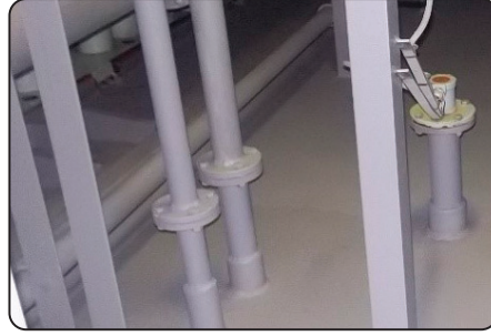
Görsel 1.20: Flanşlı borunun manşon ile tanka bağlantısı
