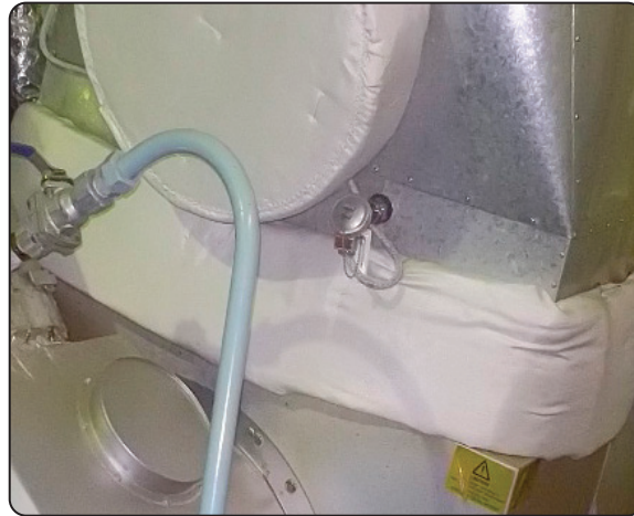
Görsel 5.4: Ana makine egzoz manifolduna RTD sensörü bağlantısı
