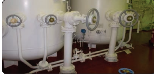
Görsel 2.19: Tüp çıkışlarına glob valf montajı
