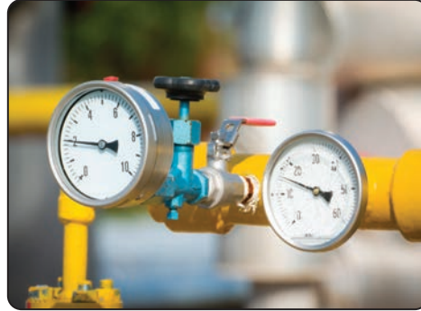
Görsel 5.12: İzolasyon ve dreyn valfli basınç sensörü bağlantısı
