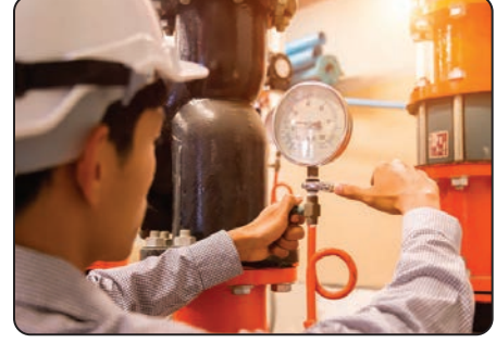
Görsel 1.33: Sifon boru ile geyç bağlantısı
