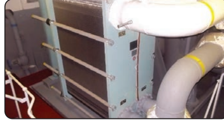
Görsel 2.25: Yağ kuleri bağlantıları
