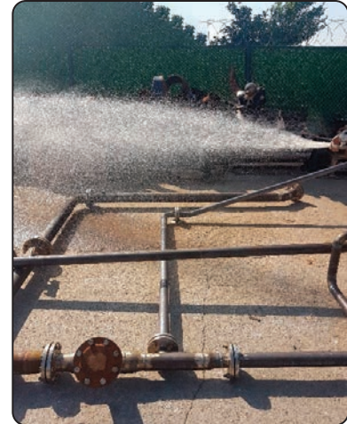
Görsel 2.44: Testin ardından basınçlı suyun dreyn edilmesi
