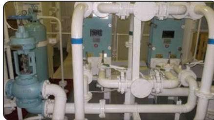
Görsel 2.32: Termostatik valf ve kuler bağlantıları
