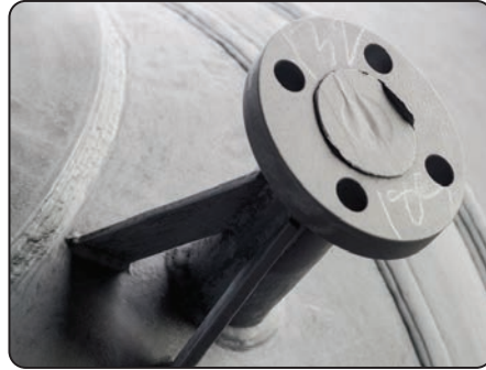
Görsel 1.21: Flanşlı borunun braket ile tanka bağlantısı
