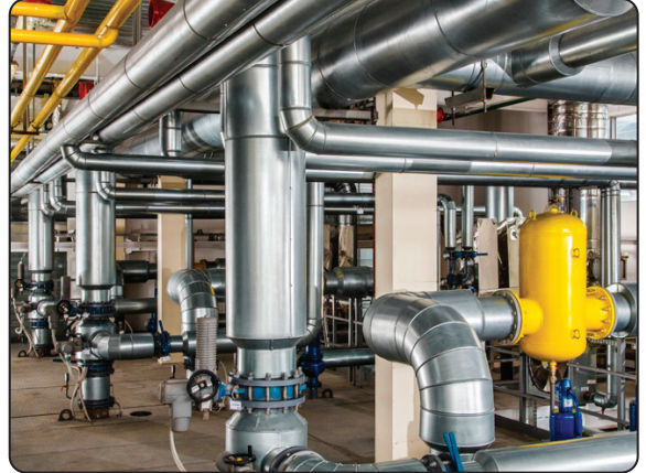
Görsel 2.53: Alüminyum sac ile izolasyon
