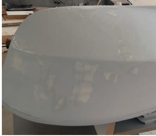
Görsel 7.5: Astar boyası atılmış yüzeye yoklama macunu uygulaması
