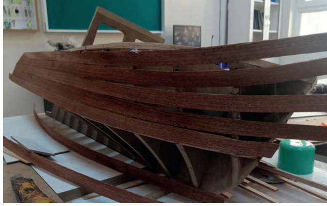
Görsel 4.4: Kaplamaların arasında oluşan boşluklar
