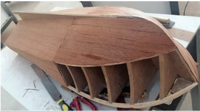
Görsel 4.6: Düz yüzeylerin tek parça kaplama ile kaplanması
