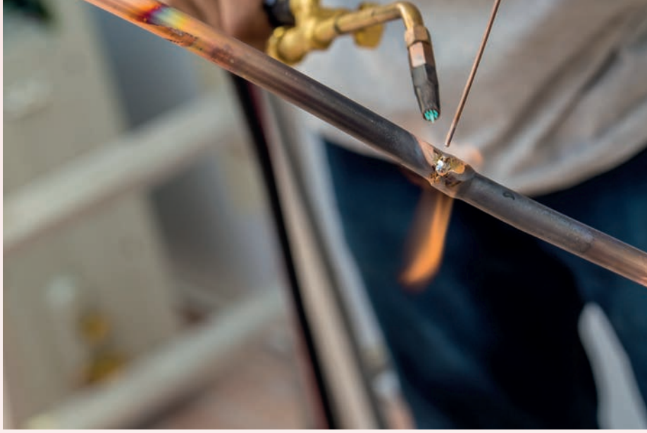
Görsel 4.11: Boruların telli kaynağı
