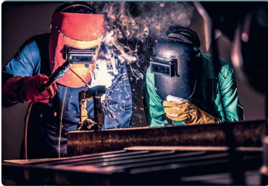
Görsel 2.1: Elektrik ark kaynağı
