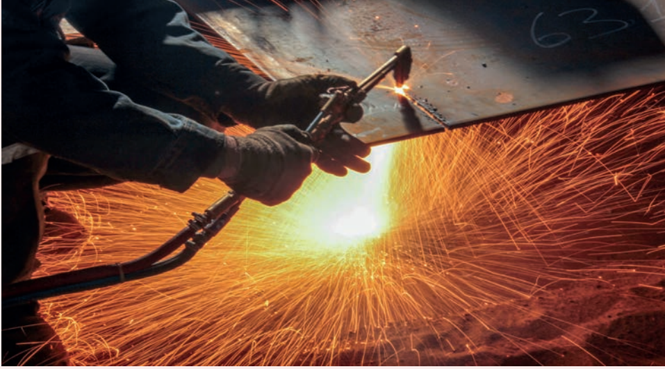
Görsel 7.6: Sac levhaların oksi-gaz ile kesimi
