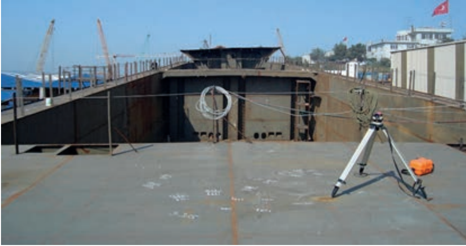
Görsel 3.10: Güverte kaplaması yapılan gemi
