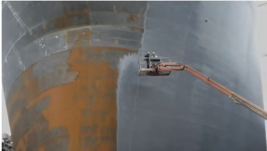
Görsel 8.5: Yüzey temizleme işlemi
