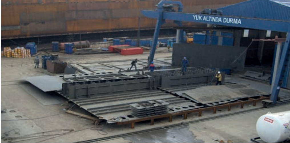
Görsel 1.14: Tank top sacı üzerindeki döşek
