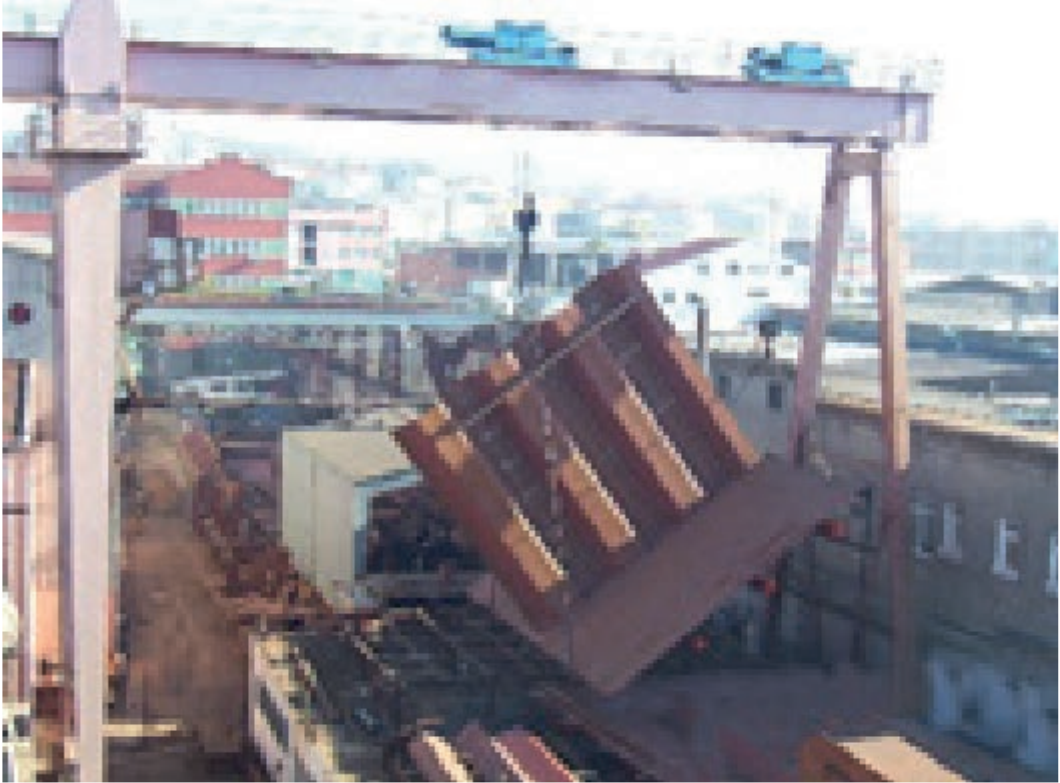
Görsel 3.8: Ondüle perde uygulaması II
