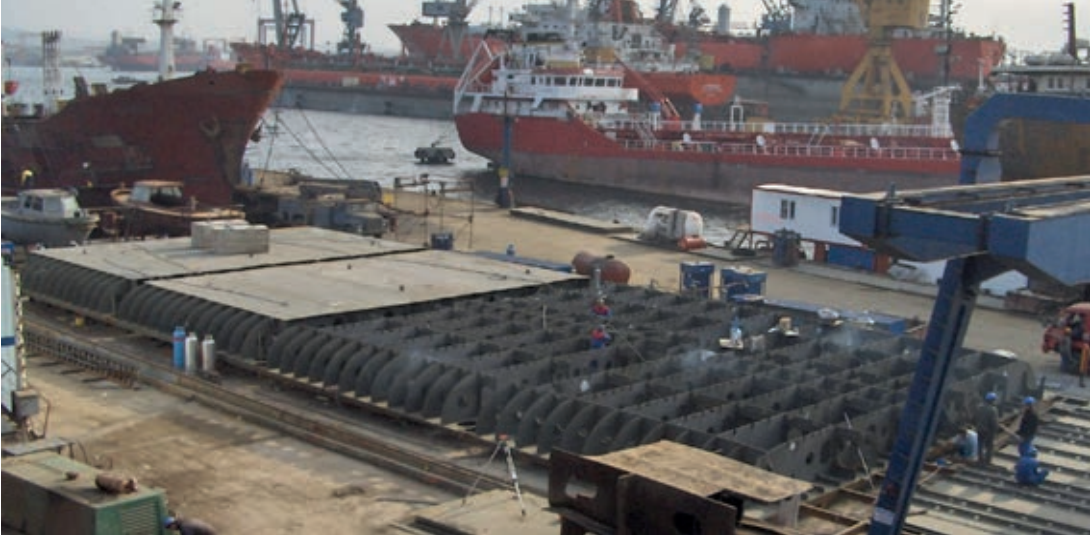
Görsel 1.15: Double bottom tankının sacının sarılması hazırlığı.
