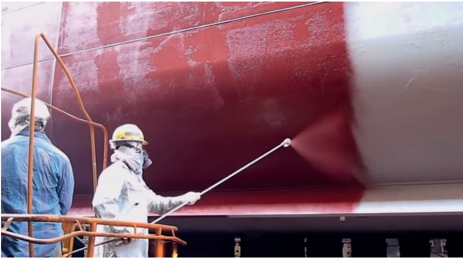
Görsel 8.22: Ara kat boya uygulaması
