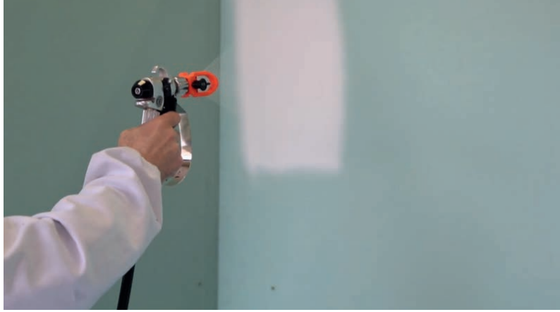
Görsel 8.36: Havalı sprej uygulama
