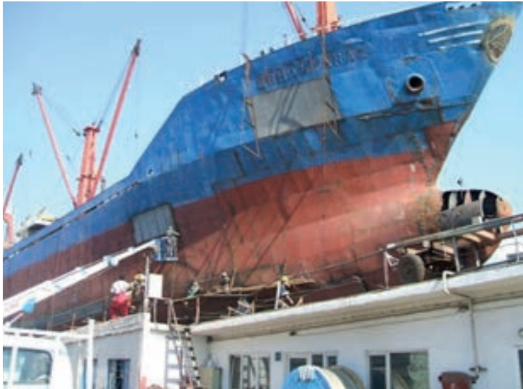
Görsel 3.23: Fazlalıkların temizlenmesi
