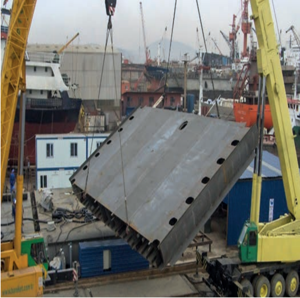
Görsel 1.17: Double bottom tankının ters çevrilmesi
