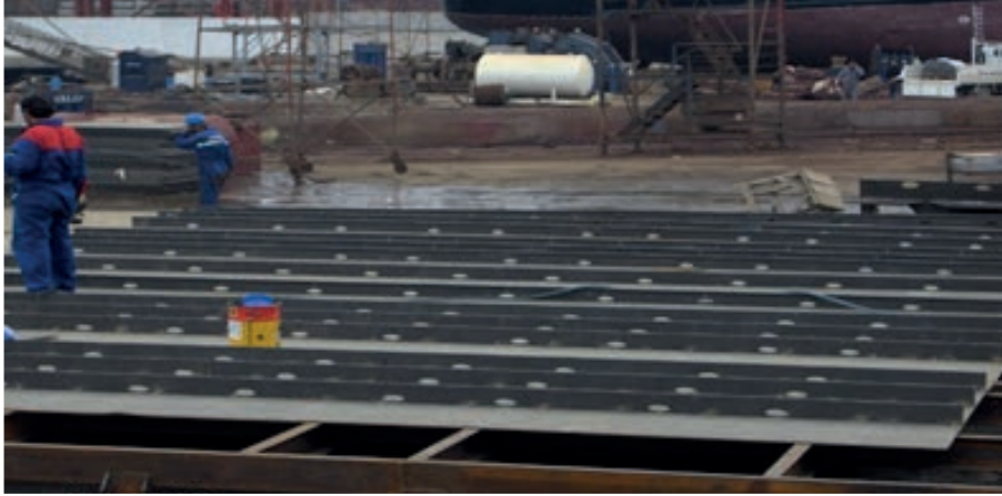
Grsel 1.12: Tank top sacı zerindeki Hollanda profilleri
