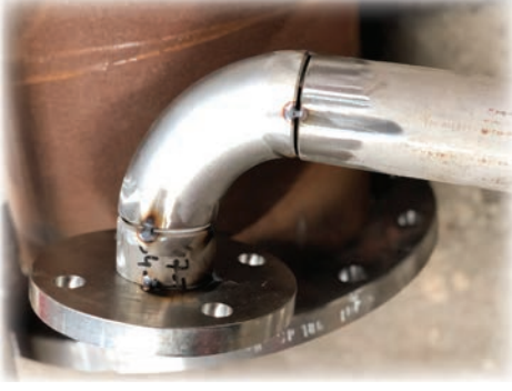
Görsel 6.8: Puntalanmış borular
