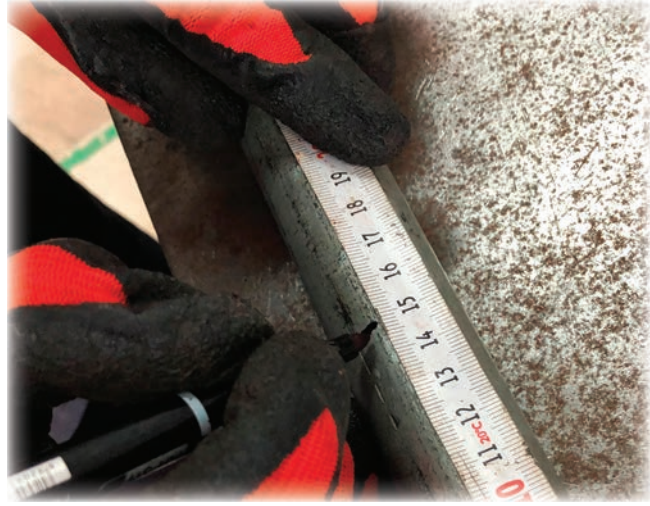
Görsel 1.8: Galvanizli borunun markalanması
