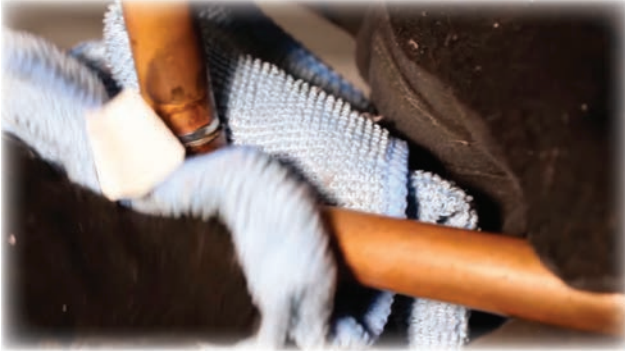
Görsel 3.30: Lehimlenen yüzeylerin temizlenmesi
