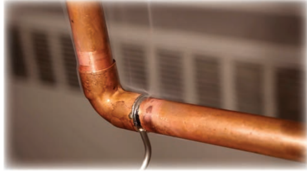
Görsel 3.29: Lehim kaynağı
