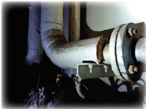
Görsel 7.11: Isıtma tesisatı boru devresinin montajı
