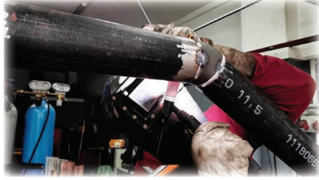
Görsel 7.8: Boru kaynağı
