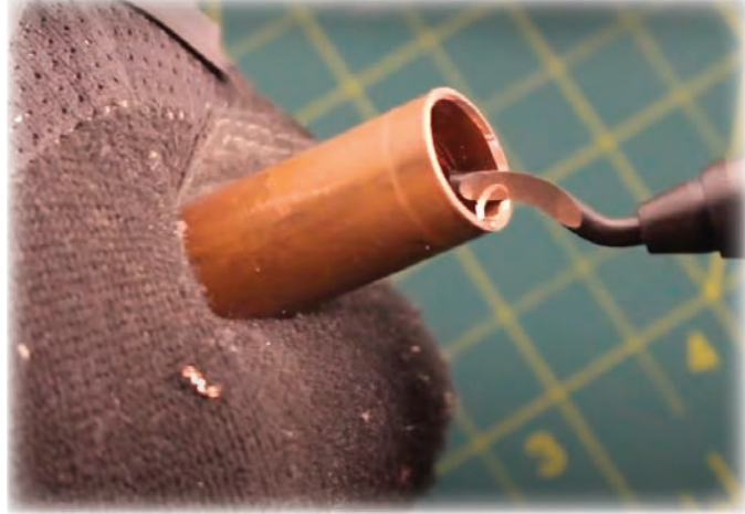
Görsel 3.10: Bakır borunun raspanması
