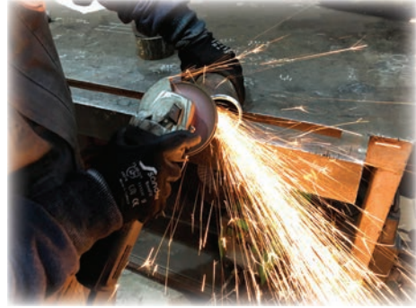
Görsel 5.4: Dış çapakların temizlenmesi
