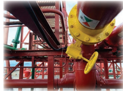
Görsel 5.16: Yangın tesisatının montajı
