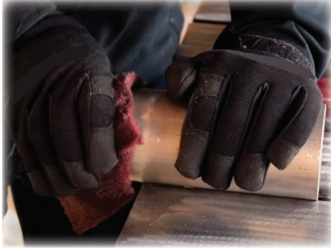
Görsel 3.39: Alüminyum borunun temizlenmesi
