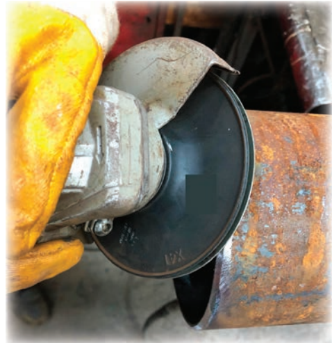
Görsel 1.27: Boruya kaynak ağızı açılması
