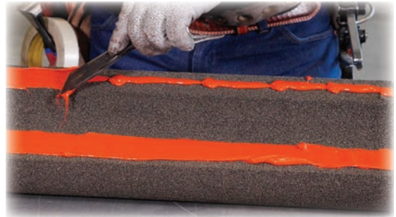
Görsel 7.21: Isıya dayanıklı silikonun yüzeylere sürülmesi
