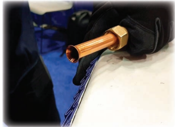
Görsel 3.17: Havşa açılmış bakır boru
