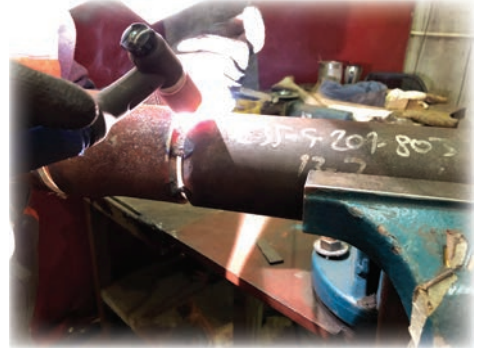
Görsel 6.18: Boruların puntalanması
