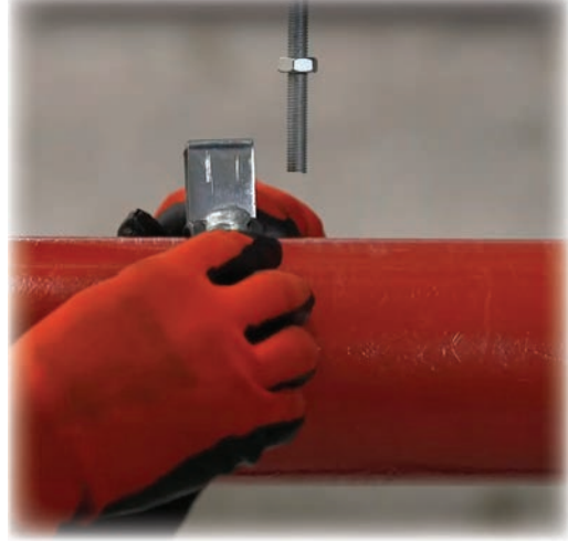
Görsel 2.4: Kelepçe çapının kontrol edilmesi
