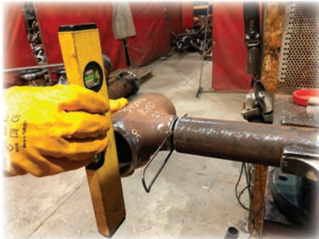
Görsel 5.11: Ana kolon hattı terazisi ve kaynak boşluğu
