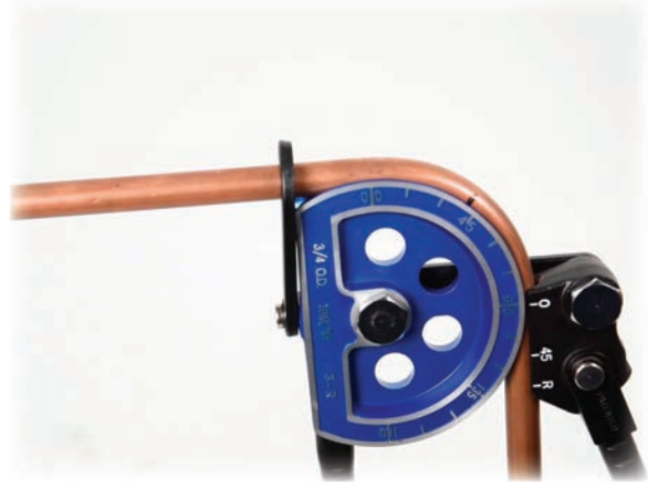
Görsel 3.21: Bakır borunun bükülmesi
