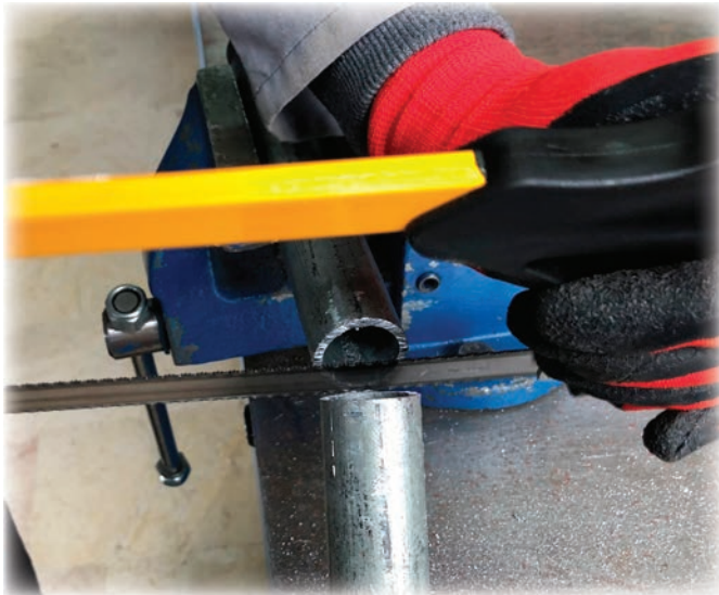
Görsel 1.9: Galvanizli borunun el testeresi ile kesilmesi
