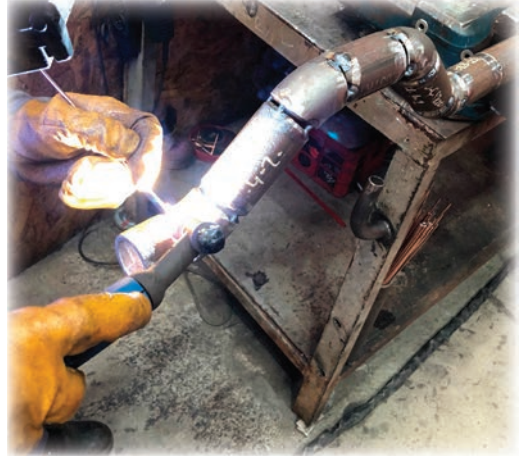
Görsel 1.22: Boru kaynağı
