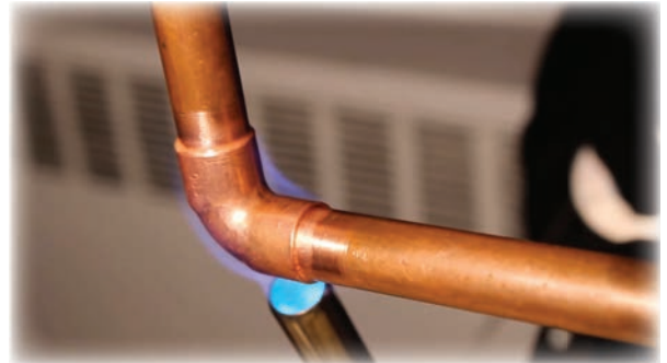
Görsel 3.27: Bakır boruların yüzeylerinin ısıtılması
