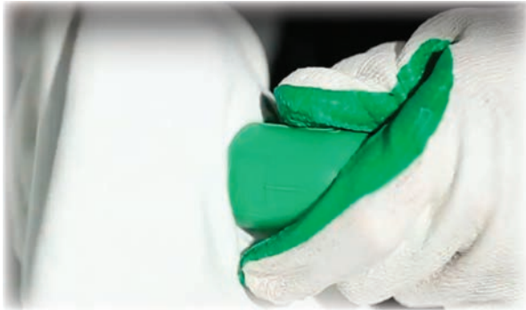
Görsel 4.6: Fittingin temizlenmesi
