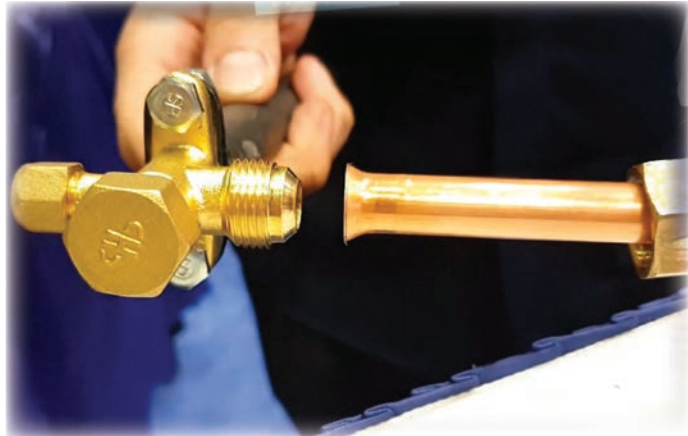
Görsel 3.23: Havşalı uç ile vidanın hizalanması
