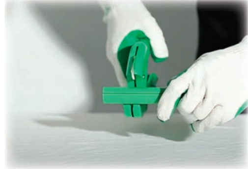
Görsel 4.5: Plastik borunun boru makası ile kesilmesi
