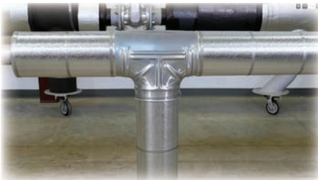
Görsel 7.26: İzolasyonu tamamlanmış boru devresi
