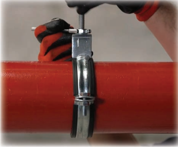
Görsel 2.8: Kelepçenin saplamaya bağlanması
