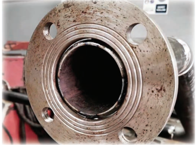
Görsel 7.6: Flanşların puntalanması
