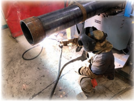
Görsel 8.3: Boruların puntalanması
