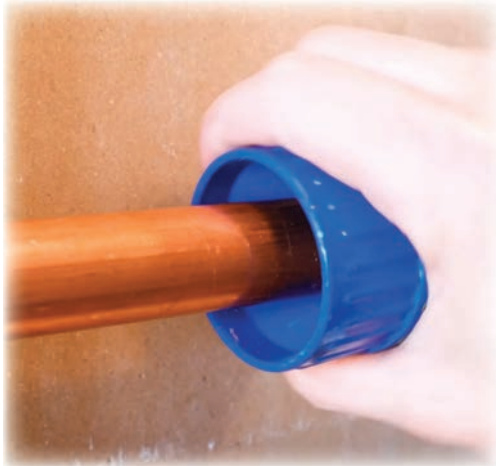
Görsel 3.11: Bakır borunun raybalanması
