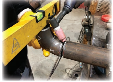
Görsel 6.9: Su terazisi ile açı kontrolü
