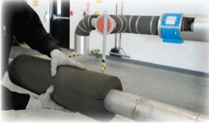
Görsel 7.22: Cam köpüğünün boru üzerine montajı
