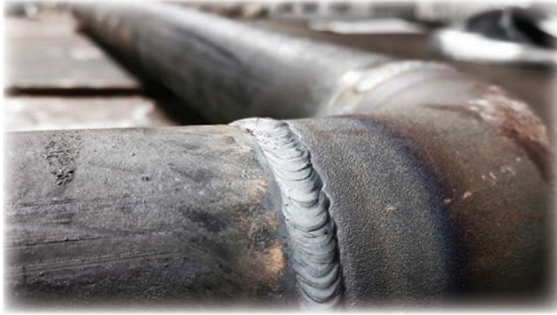
Görsel 7.9: Kaynağın gözle kontrol edilmesi
