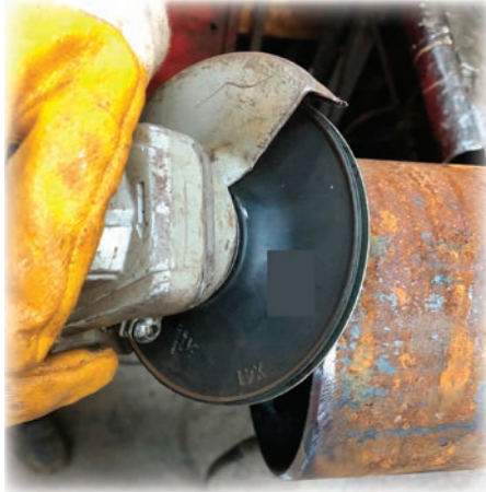
Görsel 7.3: Boruya kaynak ağızı açılması
