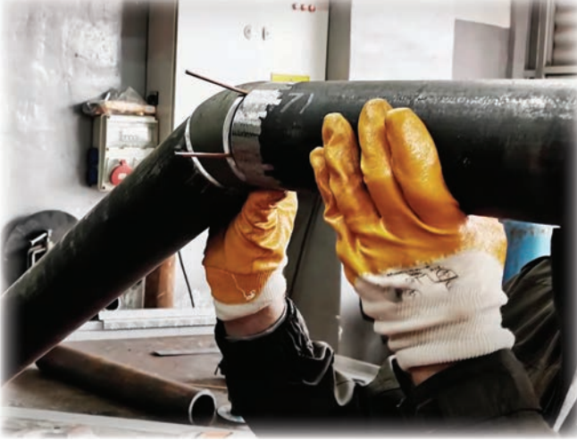
Görsel 7.5: Boruların teraziye getirilmesi
