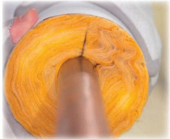
Görsel 10.17: Boru izolasyonunun son kontrolü
