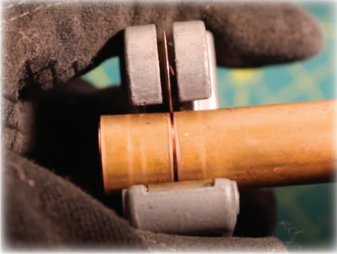
Görsel 3.6: Bakır borunun kesilmesi
