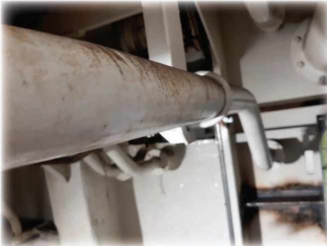
Görsel 10.5: Basınçlı hava tesisatı borularının montajı
