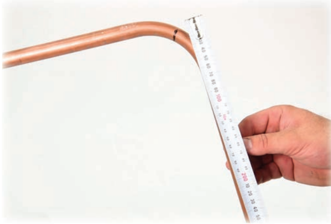
Görsel 3.22: Bükülen bakır borunun ölçü kontrolü
