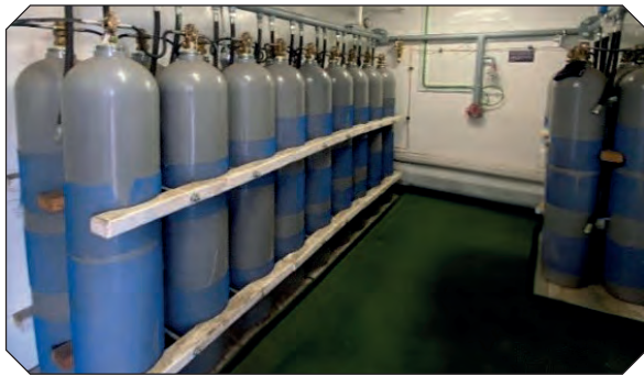
Görsel 1.5: Karbondioksit devre bağlantıları
