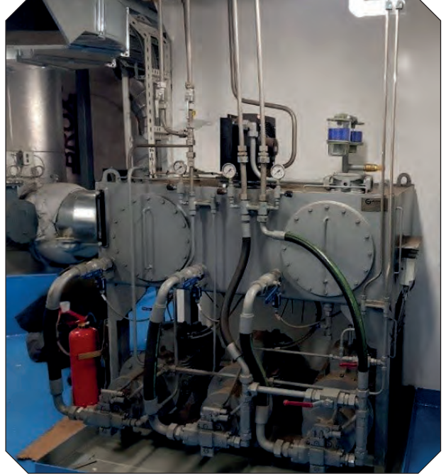
Görsel 1.11: Hidrolik boru bağlantıları
