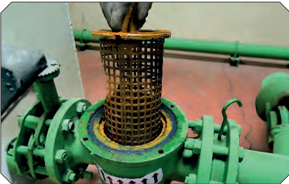
Görsel 3.46: Filtre elemanının çıkartılması
