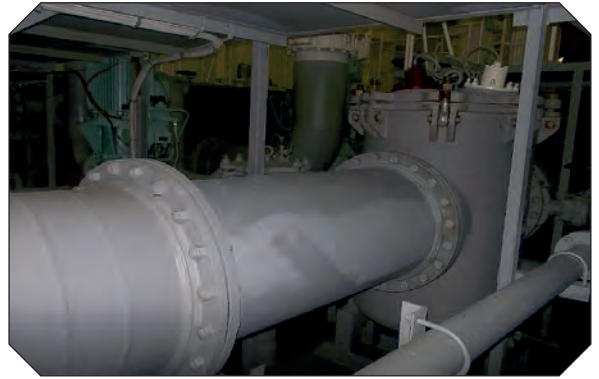
Görsel 1.2: Balast devresinin kinistin boru bağlantısı
