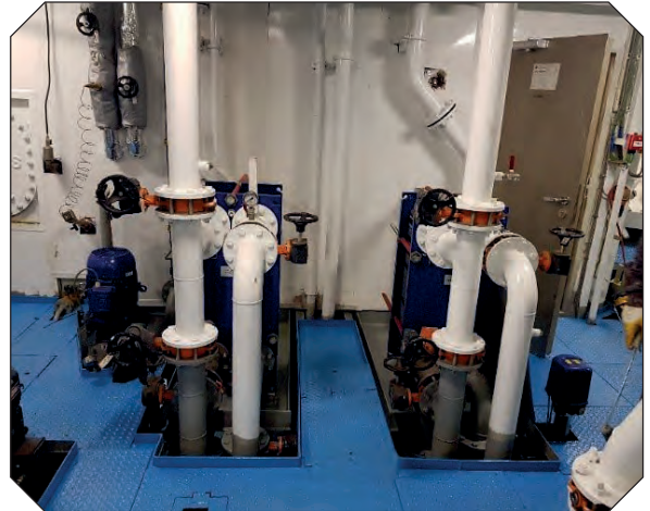
Görsel 1.8: Soğutma devreleri ile ısı değiştiricilerin bağlantıları
