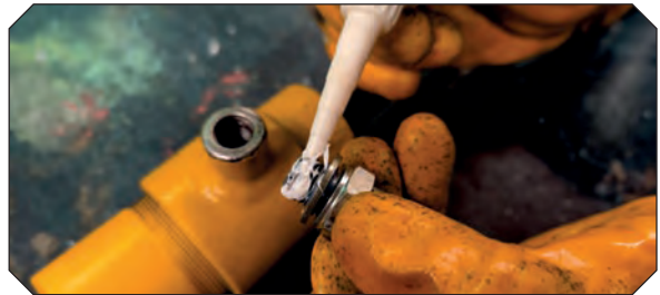
Görsel 4.88: Bağlantı elemanı dişlerine sıvı conta sürme
