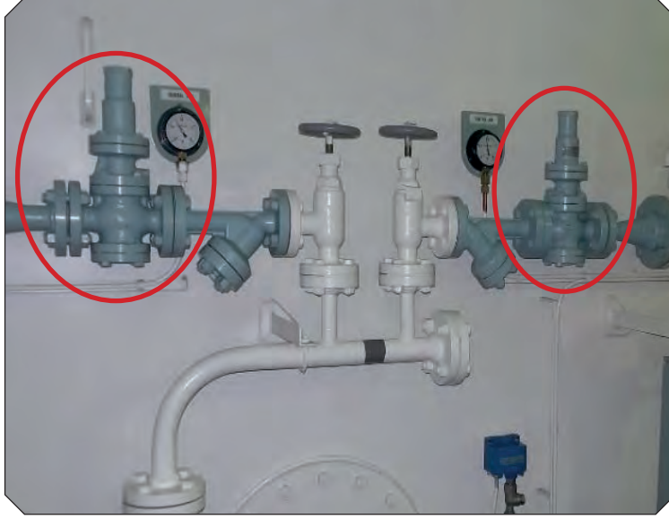
Görsel 2.75: Hava devresi üzerindeki basınç kısma valfleri
