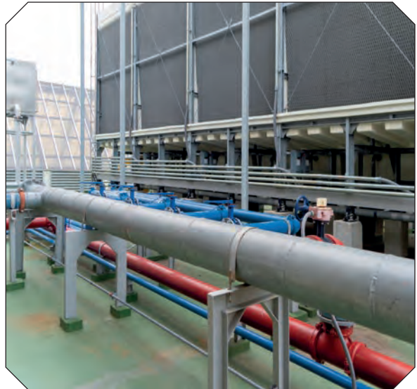
Görsel 1.16: Boru hattının desteklenmesi
