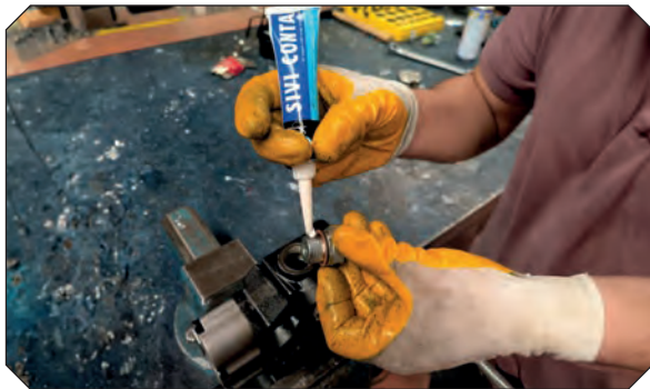
Görsel 4.69: Sıvı conta sürülen bağlantı elemanı
