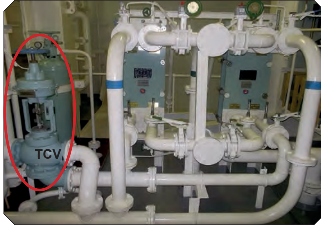
Görsel 2.78: Sıcaklık kontrol valfi (TCV) ve soğutma suyu bağlantıları
