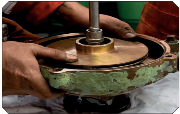
Görsel 3.52: Yenilenen çarkın yerleştirilmesi
