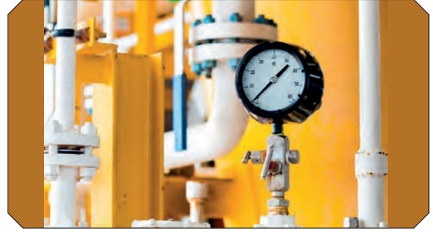
Görsel 2.55: Manometre önüne iğne valf montajı
