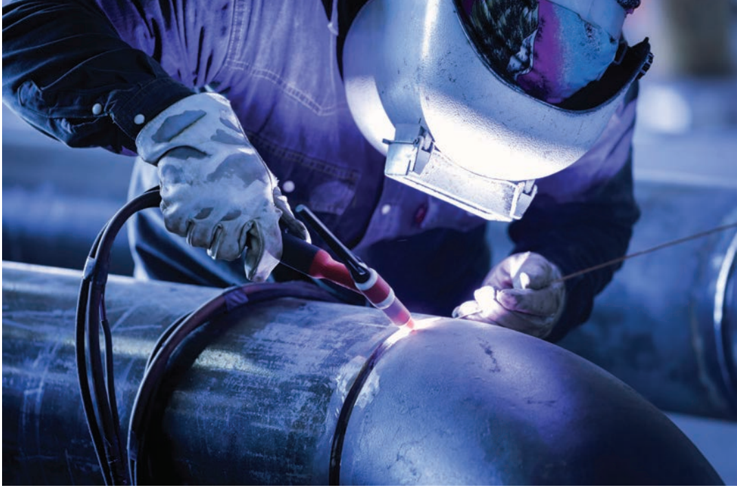
Görsel 5.6: TİG boru kaynağında elektrot tutuluşunun görünüşü
