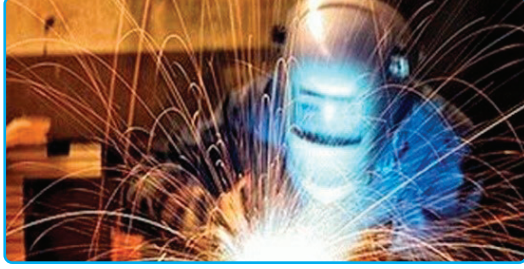
Görsel 2.25: Çelik boruların puntalanması
