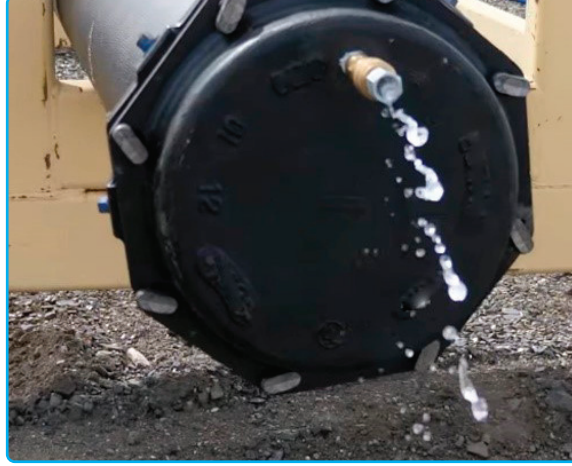
Görsel 4.16: Boru içerisindeki çapak ve havanın dışarı atılması
