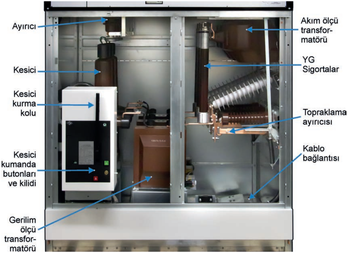
Görsel 1.4: Metal muhafazalı modüler hücrenin anahtarlama ve kablo bağlantı bölümü
