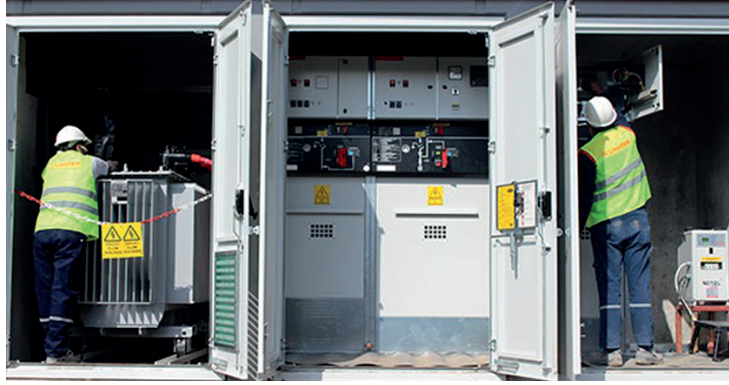
Görsel 1.70: Metal muhafazalı modüler hücrelerin bakımları
