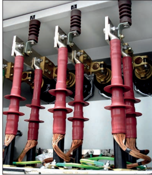
Görsel 1.52: MMMH'de giriş-çıkış orta gerilim kablosu başlığının montajı
