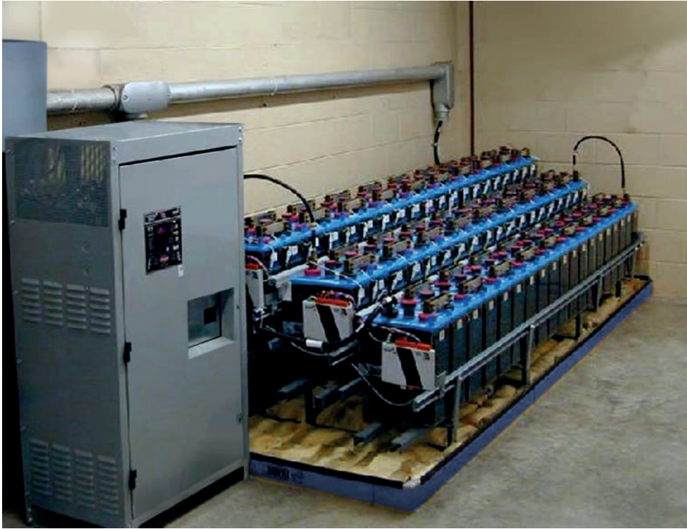
Görsel 3.2: Akü odasında doğrultucu ve akülerin yerleşimi
