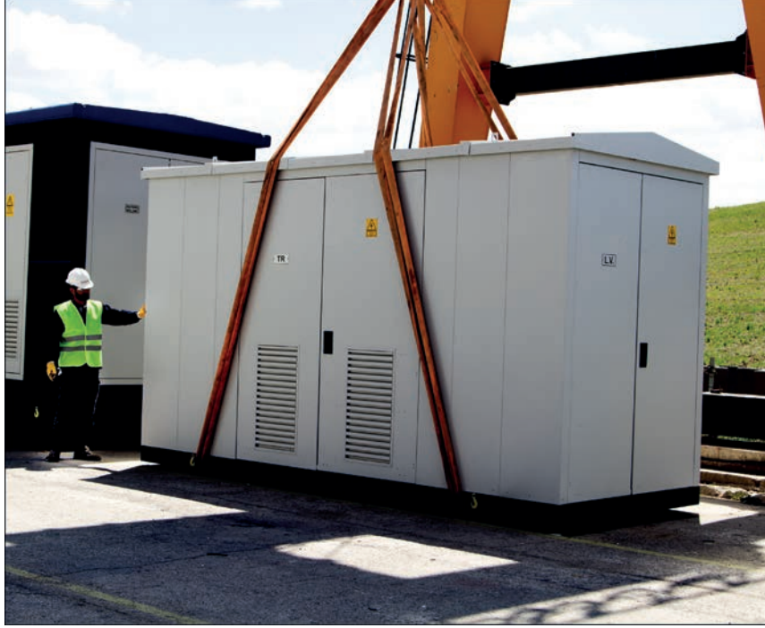
Görsel 1.39: Köşkün taşınıp yerleştirilmesi
