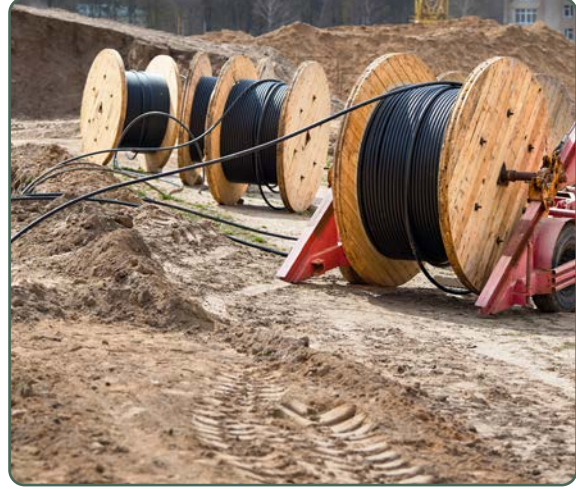
Görsel 6.3: Yer altı kablolarının döşenmesi
