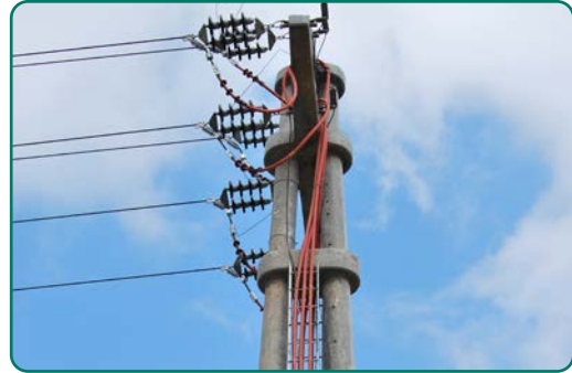
Görsel 5.5: Çift santrifüj beton direk
