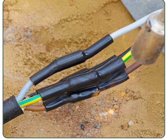
Görsel 6.4: Yer altı kablosunun eklenmesi
