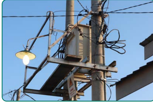
Görsel 5.16: Orta gerilim beton trafo direği
