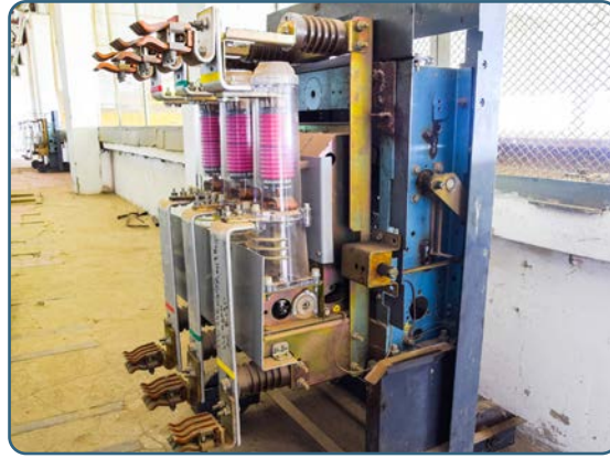
Görsel 3.8: Vakumlu tip kesici
