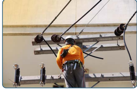
Görsel 3.10: Ayırıcı montajı
