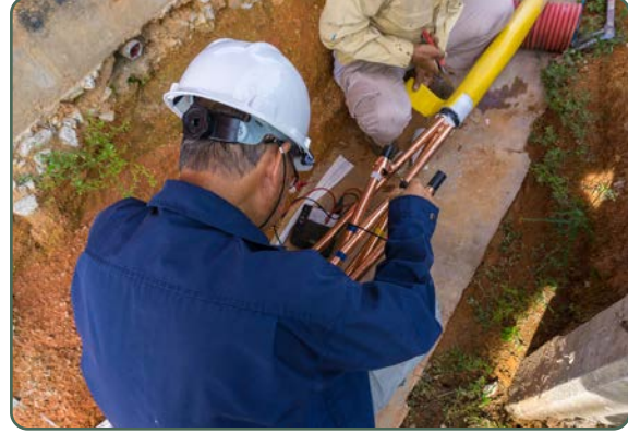
Görsel 6.6: Yer altı kablosunun eklenmesi
