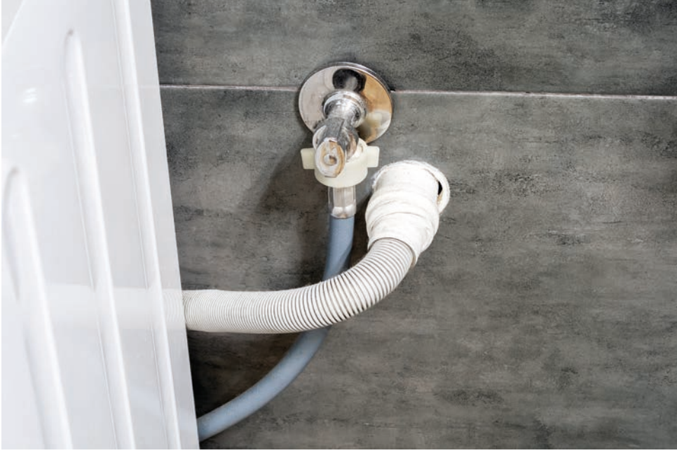
Görsel 5.2: Bulaşık makinesinin atık su bağlantısı
