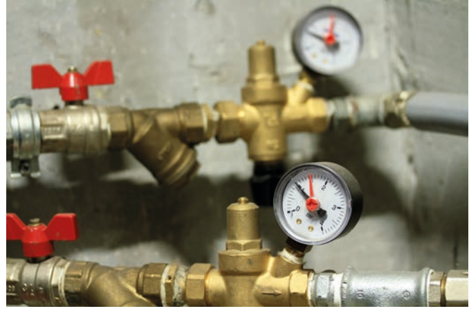
Görsel 1.9: Şebekeye bağlantısı yapılmış bir manometre
