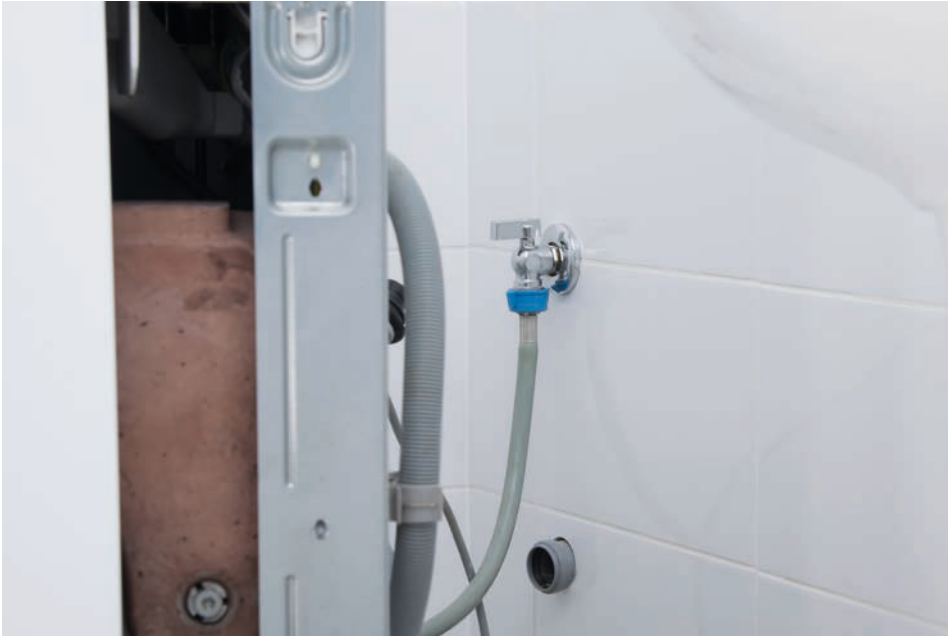
Görsel 5.1: Bulaşık makinesinin temiz su kaynağına bağlantısı
