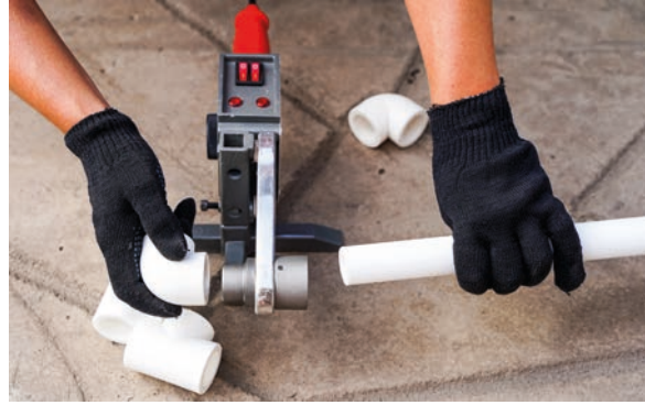
Görsel 1.15: PVC boru kaynak makinesi ile kaynak yapmak.
