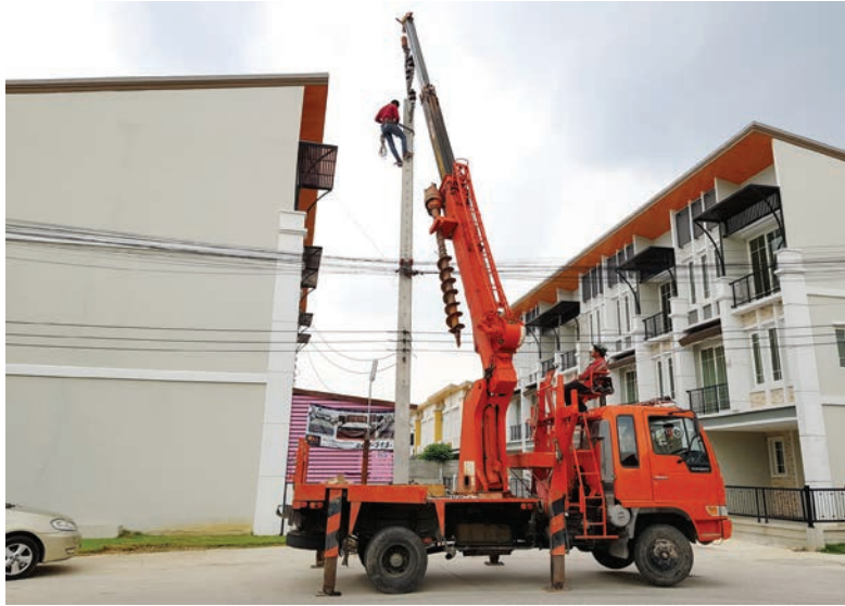
Görsel 7.15: Aydınlatma direğinin dikilmesi
