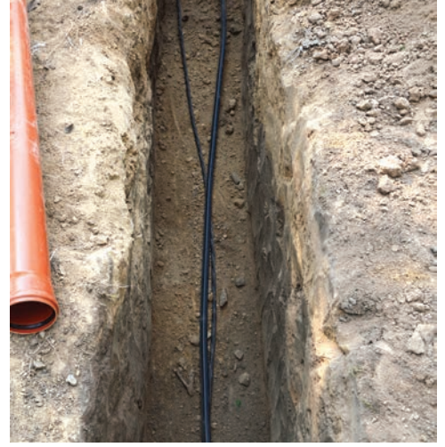
Görsel 7.16: İletkenlerin kanala döşenmesi
