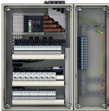
Görsel 6.24: Tali dağıtım panosu
