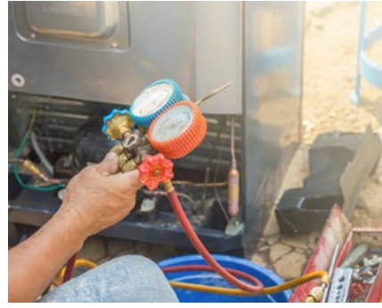
Görsel 2.24: Manifold ile ölçüm yapma işlemi
