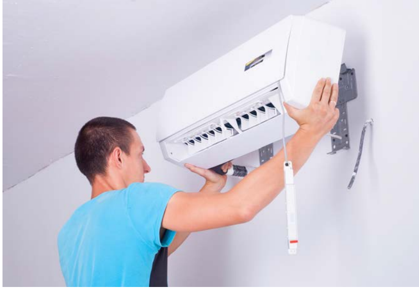
Görsel 3.13: Klima montajı
