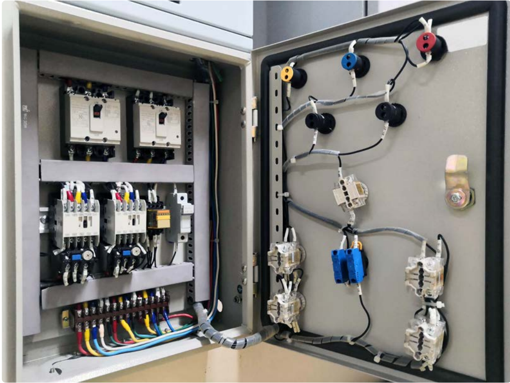
Görsel 1.39: Kumanda devre elemanlarının montajı
