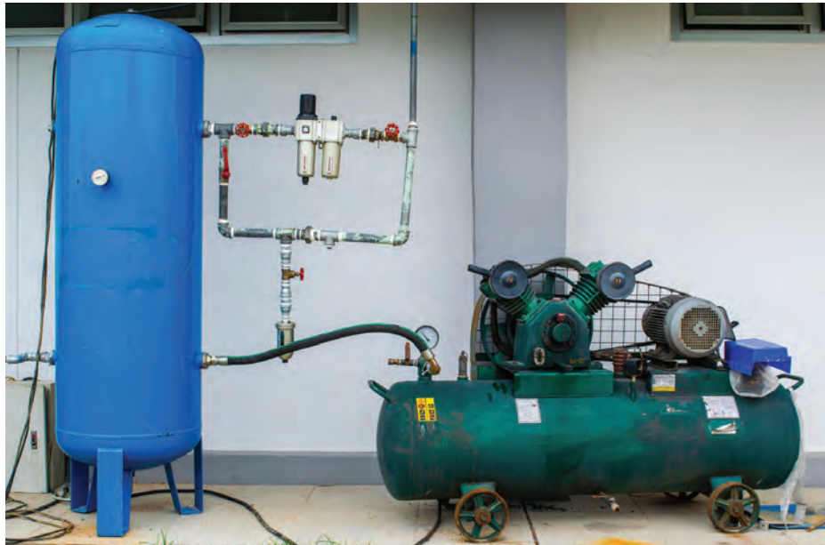
Görsel 4.3: Basınçlı hava tankı ve kompresör
