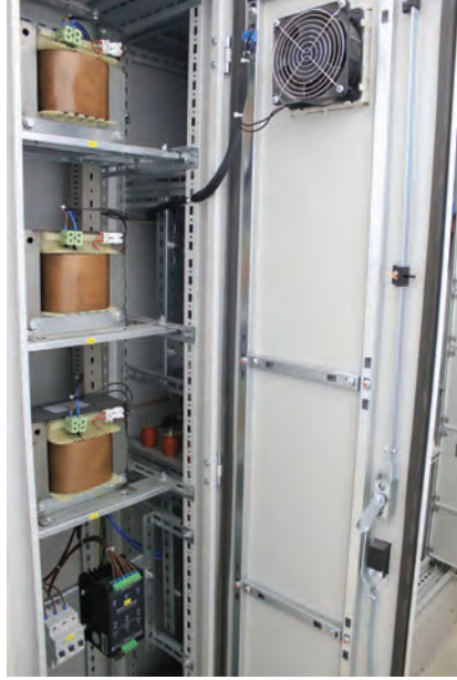
Görsel 11.8: Kompanzasyon panolarında reaktörler ve reaktör sürücüsü
