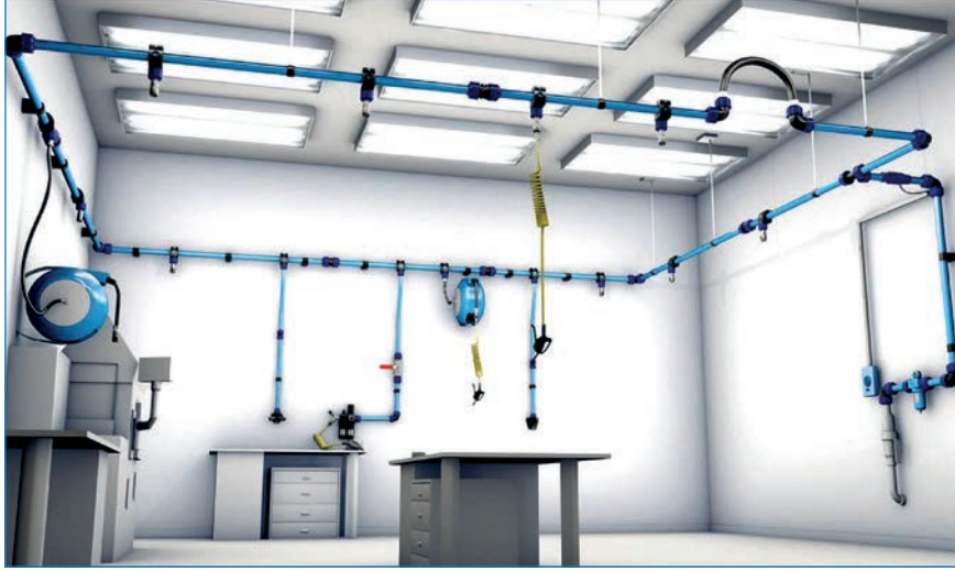
Görsel 1.55: Basıncılı hava hattı borularının tavana ve duvara montajı
