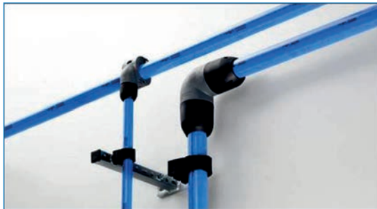
Görsel 1.54: Ana dağıtım hattı borularının duvara sabitlenmesi
