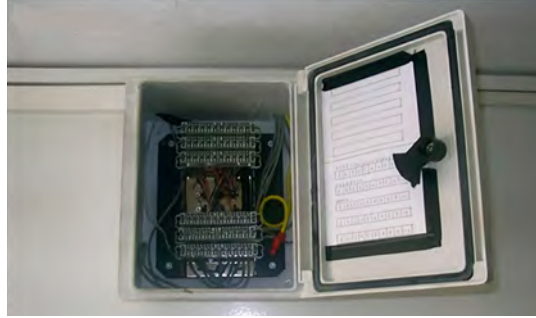
Görsel 5.31: Telefon terminal kutusu bağlantıları
