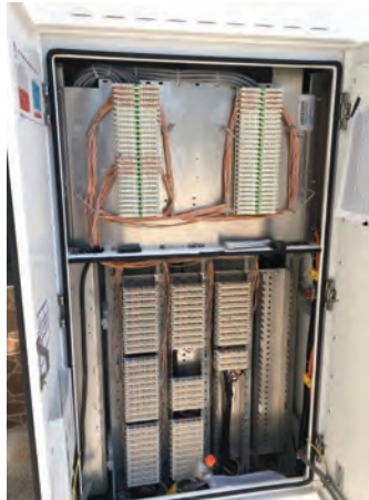
Görsel 5.11: Saha dolabının iç ve dış görüntüsü
