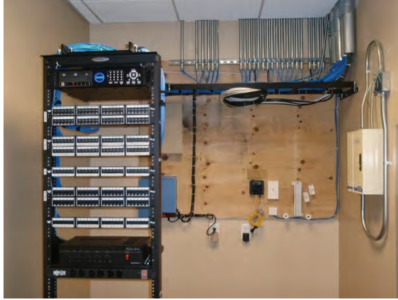
Görsel 5.6: Elektronik haberleşme sistem odası
