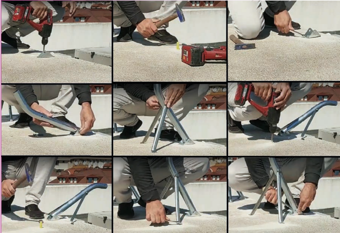
Görsel 2.39: Çanak antenin montajı
