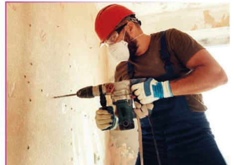
Görsel 2.31: Matkapla duvar delme işlemi
