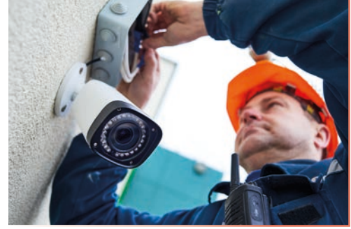
Görsel 3.47: Güvenlik kamerasının kurulumu
