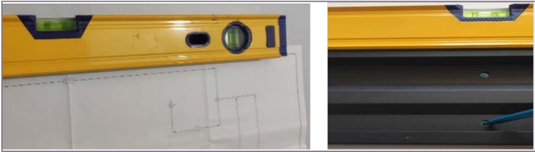
Görsel 6.22: Dübel yerlerinin işaretlenmesi (1. model ve 2. model)
