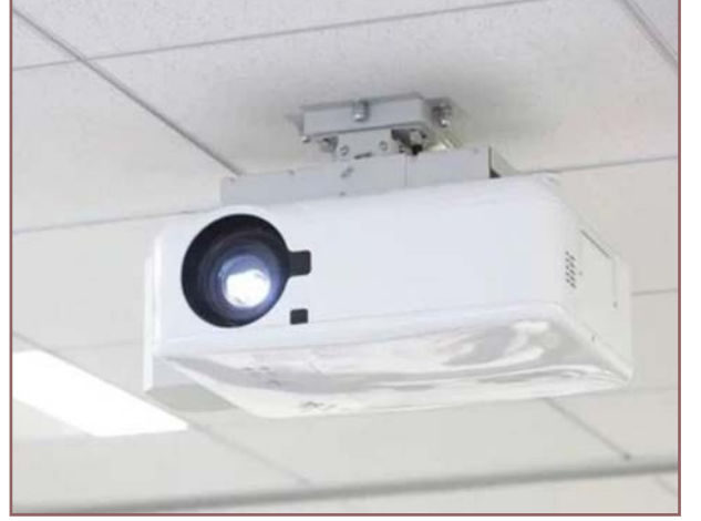
Görsel 3.15: Projektör tavan montajı
