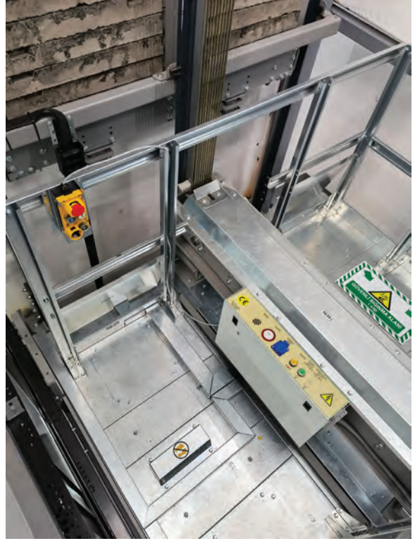
Görsel 3.3: Kabin ağırlığının denge kontrolü
