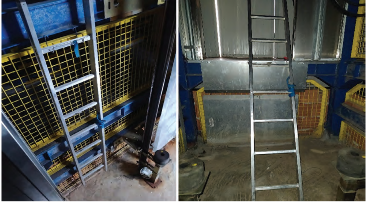
Görsel 2.10: Kuyu dibi iniş merdiveni
