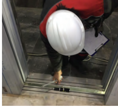
Görsel 1.12: Newtonmetrenin kullanımı
