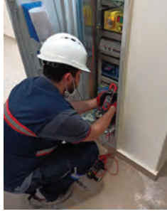
Görsel 3.2: Topraklama kontrolü
