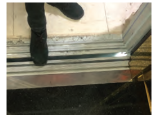
Görsel 3.15: Katta durma seviyesinin kontrolü
